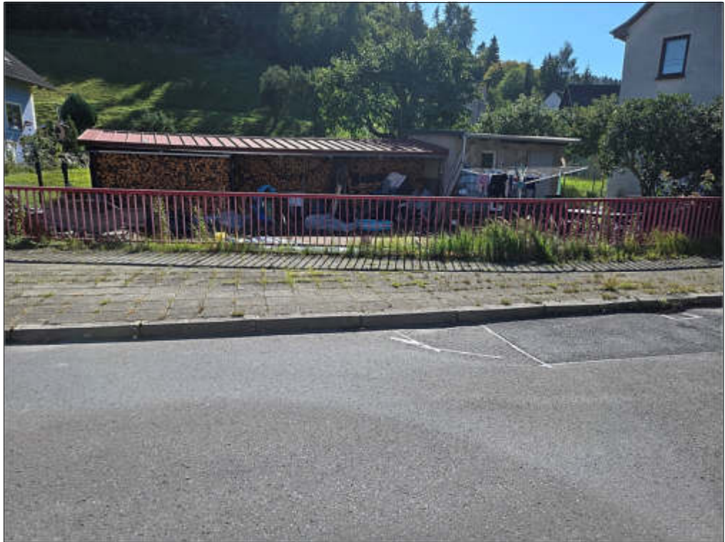
Bild 12 BBT Nebengebäude / Überdachung
