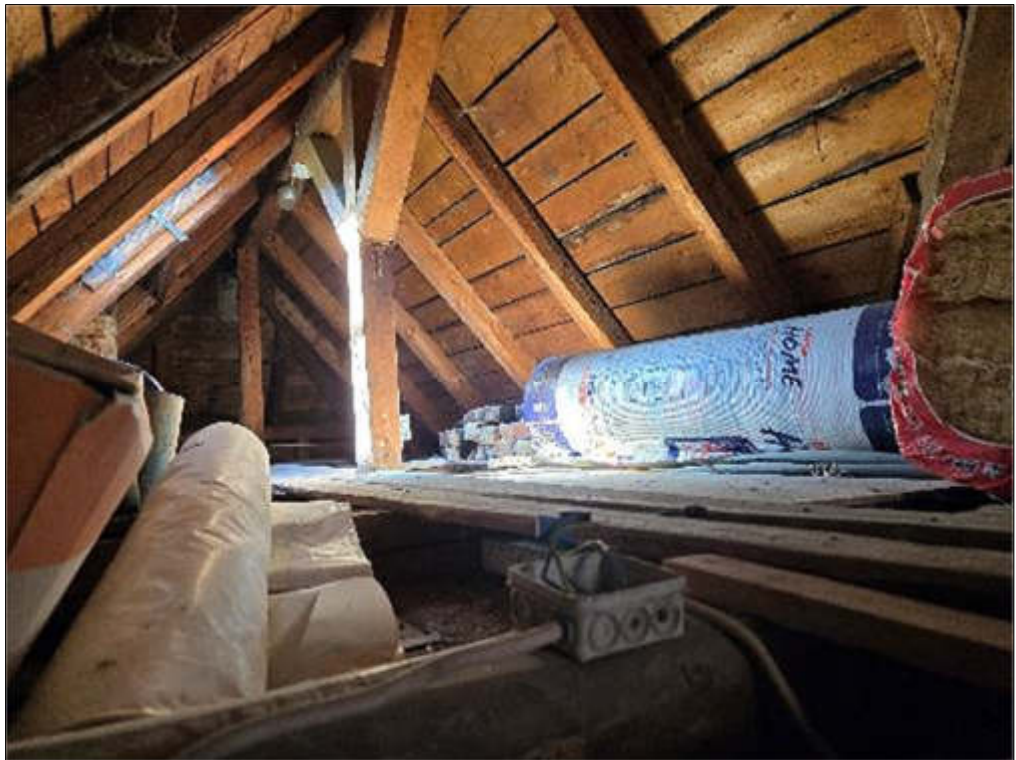
Bild 11 Pos. 01 Wohnhaus, innen, Spitzboden
