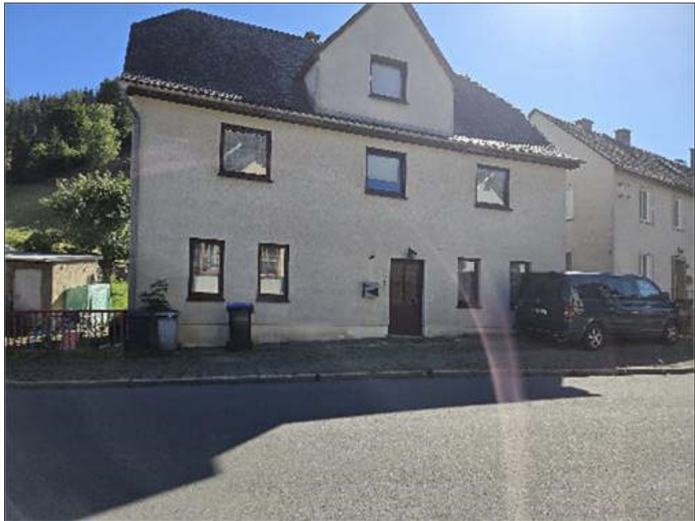
Bild 3 Pos. 01 Wohnhaus, Nordseite
