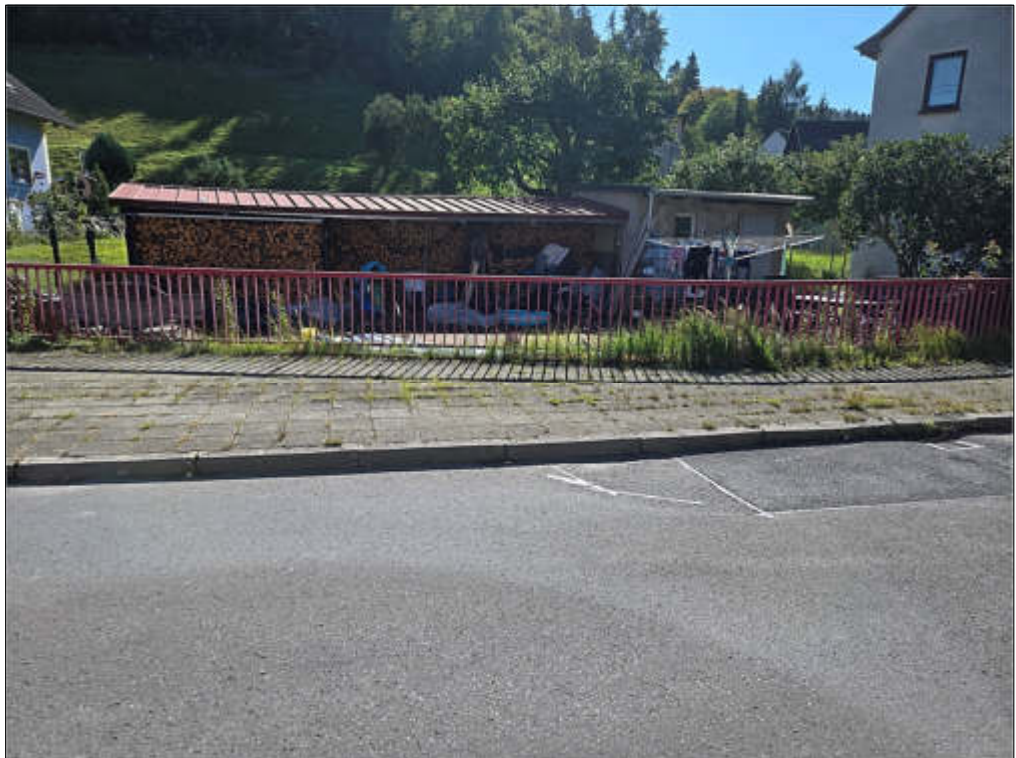
Bild 12 BBT Nebengebäude / Überdachung
