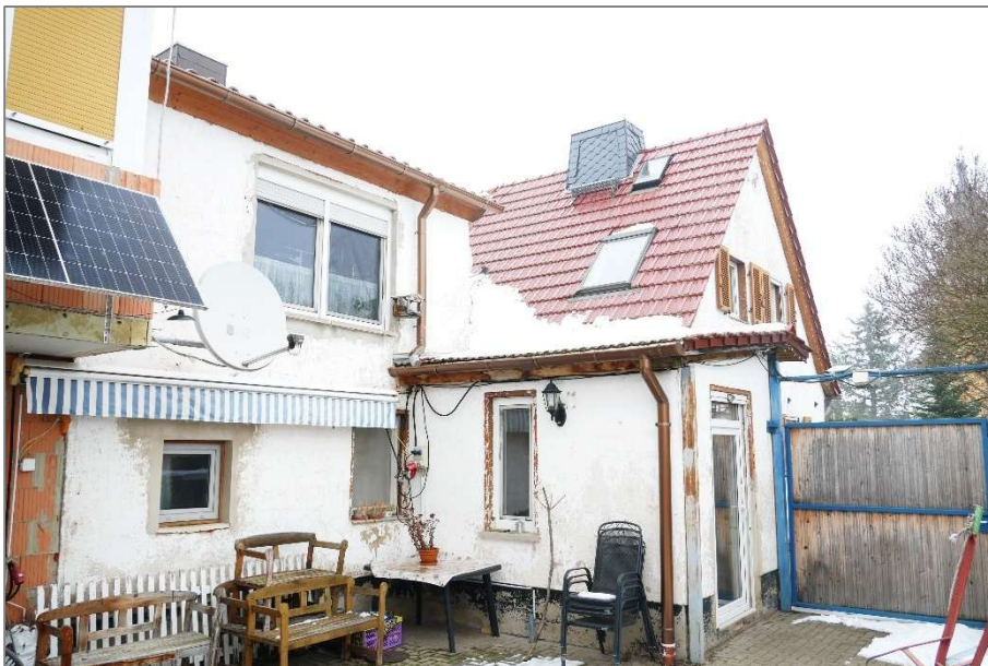
Wohnhaus / Vorderhaus - Südwestansicht
