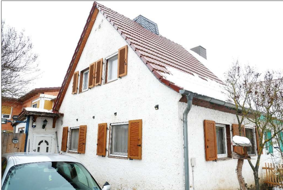
Wohnhaus / Vorderhaus - Südostansicht
