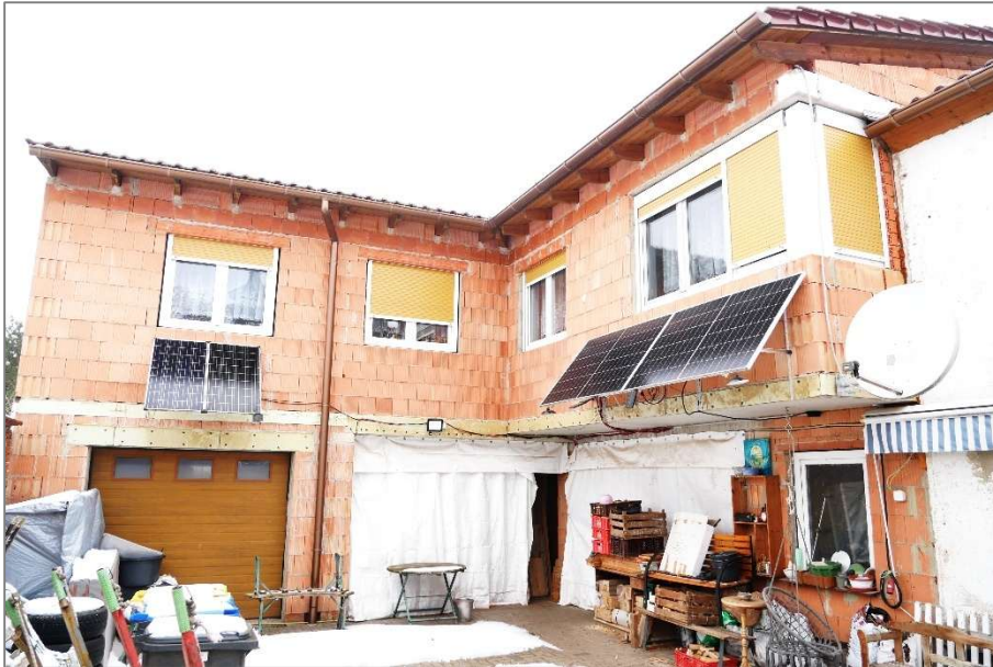
Wohnhaus / Hinterhaus - Ostansicht
