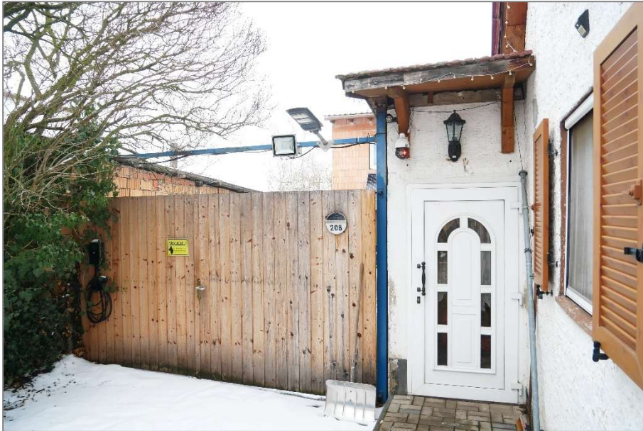
Wohnhaus / Vorderhaus - Windfanganbau und Zufahrt
