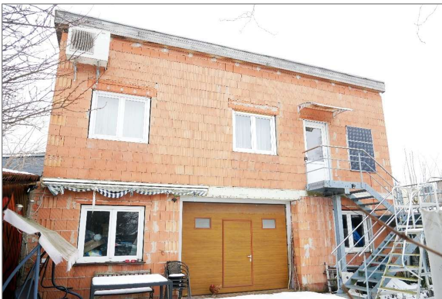
Wohnhaus / Hinterhaus - Westansicht
