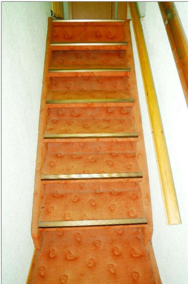
Foto 10 - Wohnhaus - Treppe vom EG zum OG
