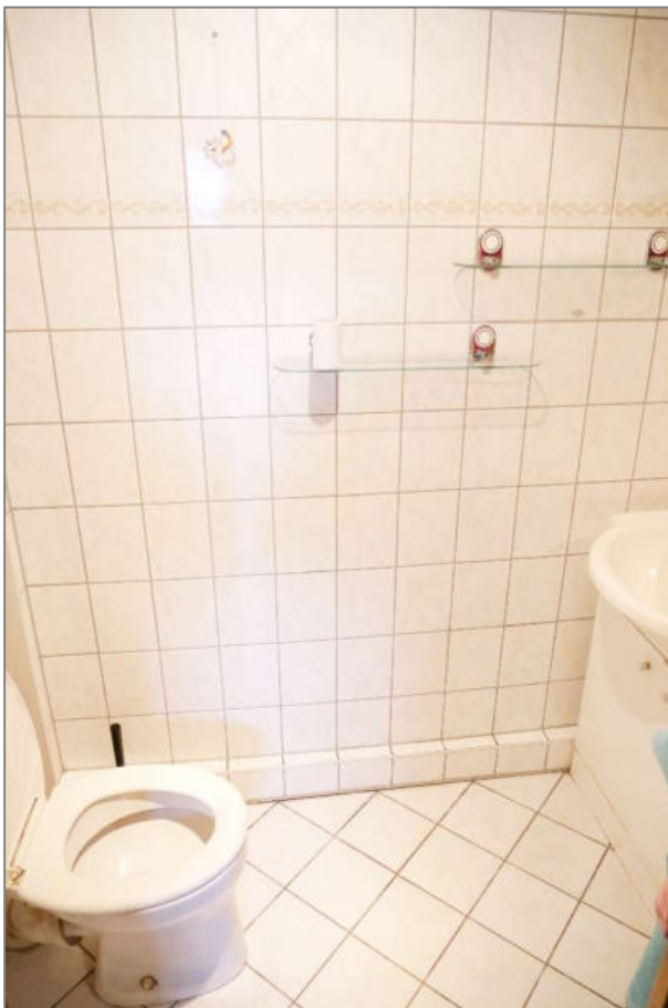
Foto 12 - Wohnhaus - Toilette OG
