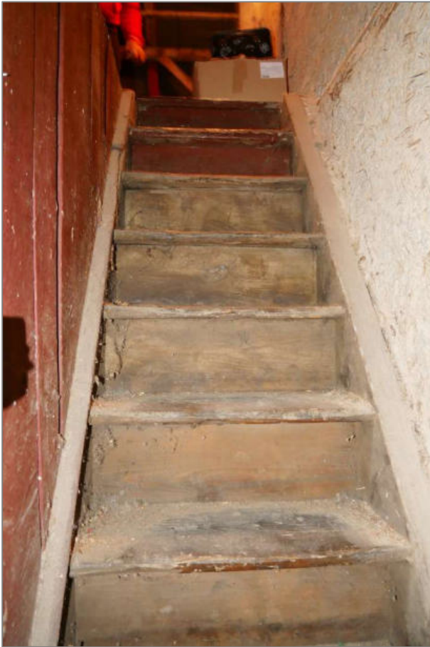
Foto 15 - Wohnhaus - Treppe zum Dachboden
