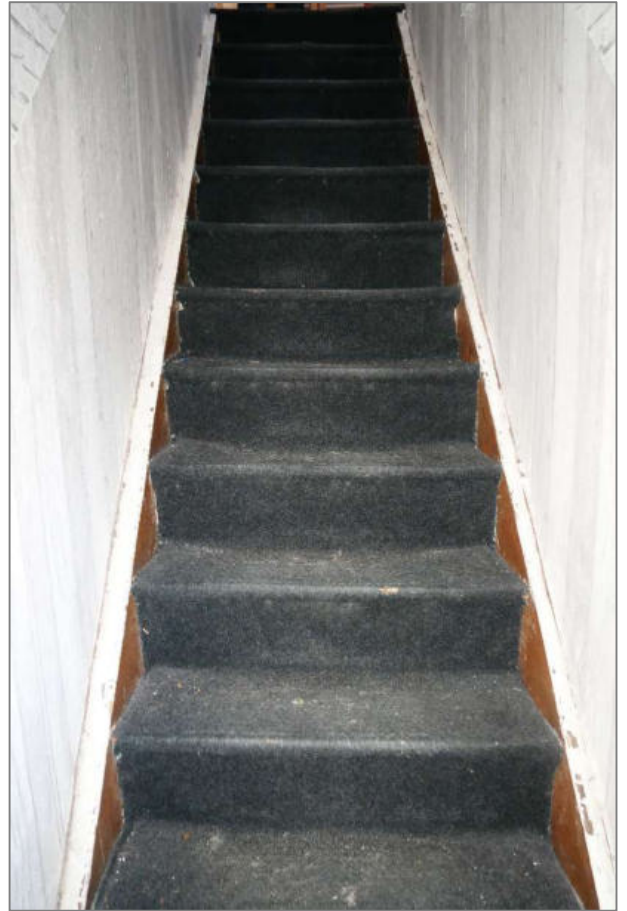
Foto 6 - Wohnhaus - Treppe vom EG zum OG
