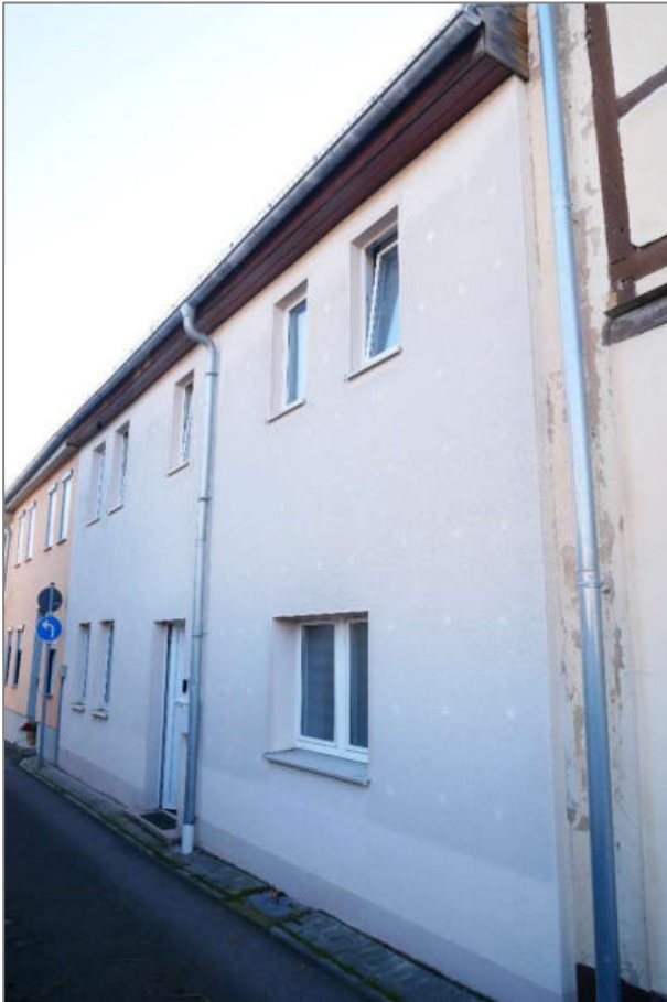
Foto 1 - Wohnhaus - Nordwestansicht (Straßenansicht)
