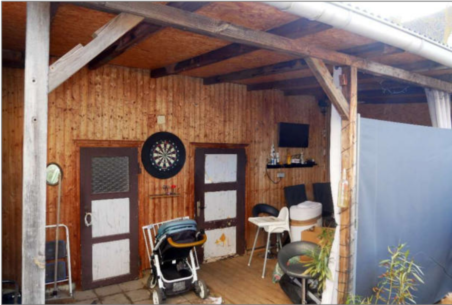
Foto 17 - Nebengebäude und überdachter Freisitz - Ostansicht
