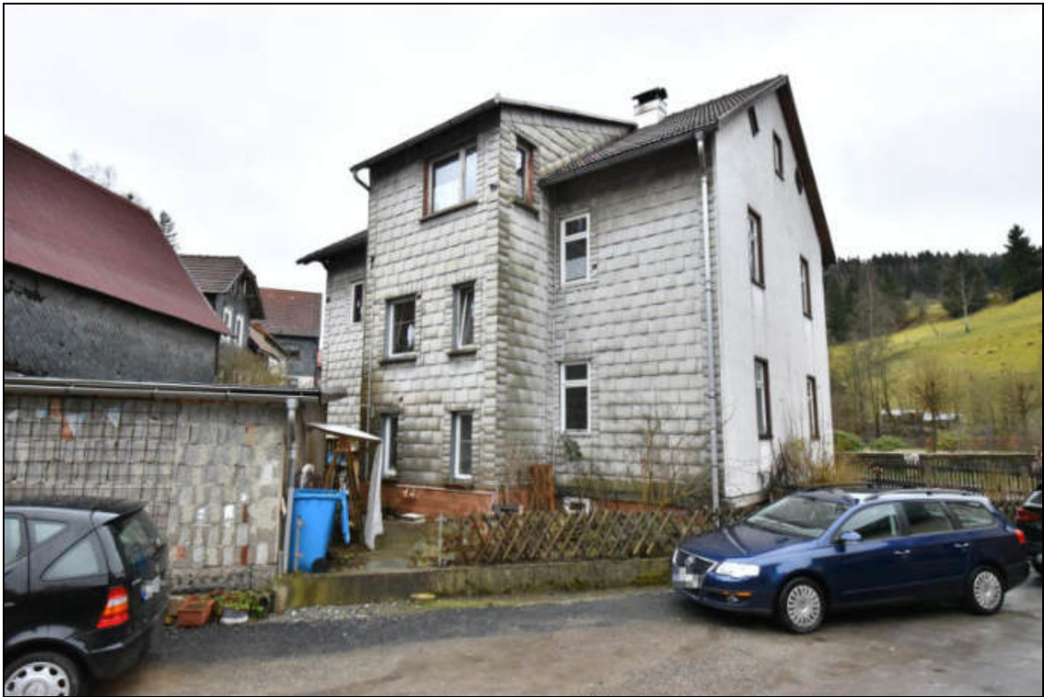
Gebäudehinterseite mit Asbestfassade und Nebengebäude (links) Nordwestansicht
