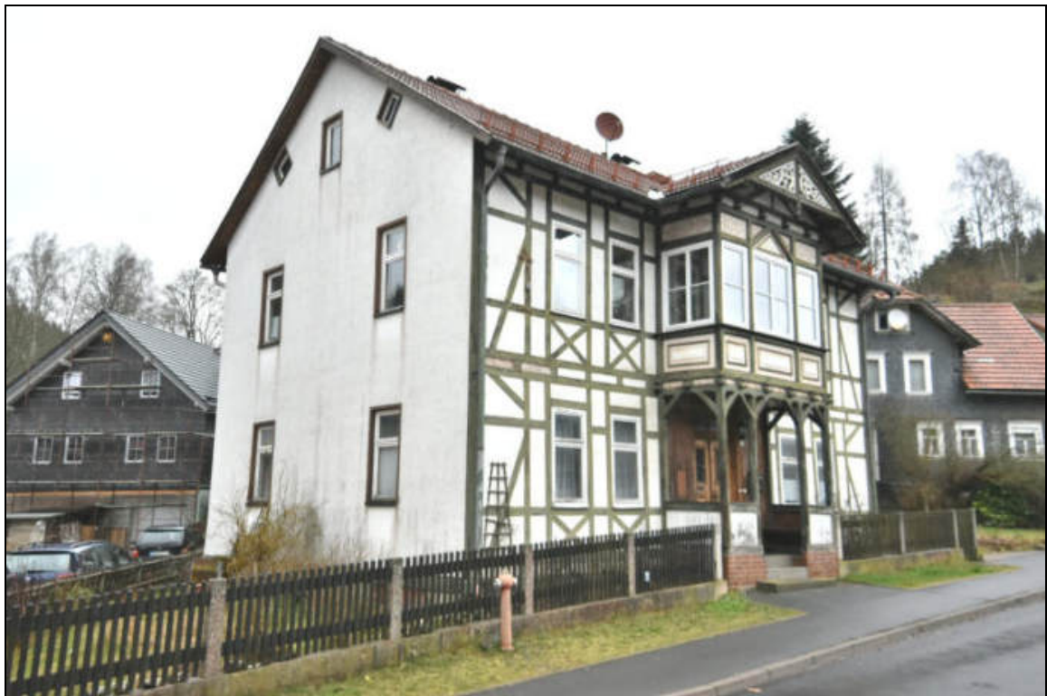
Südansicht mit Wärmedämmfassade
