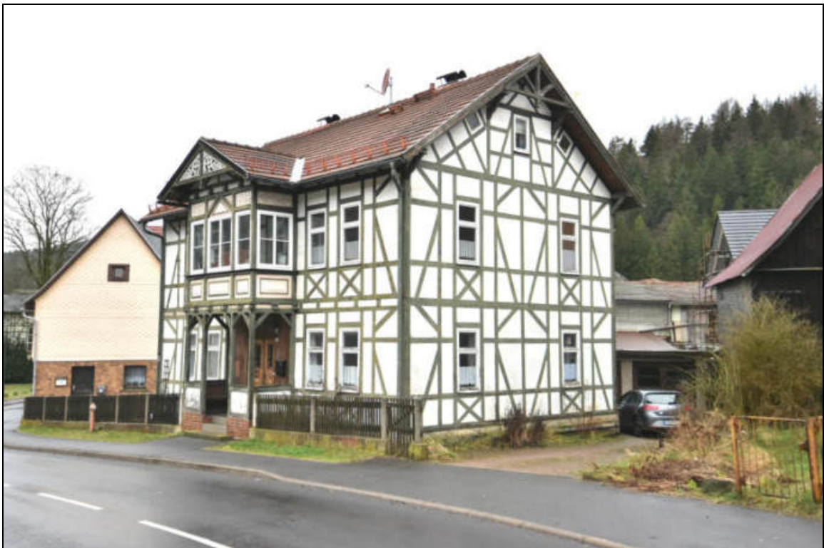
Ostansicht mit Zufahrt und hinterliegendem Nebengebäude
