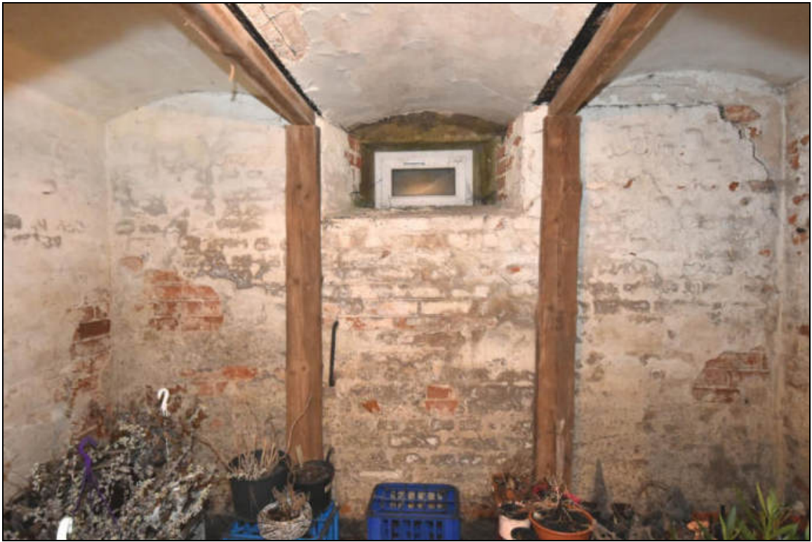
Kellerraum mit vorgenommener provisorischer Abstützung der schadhaften Kellerdecke
