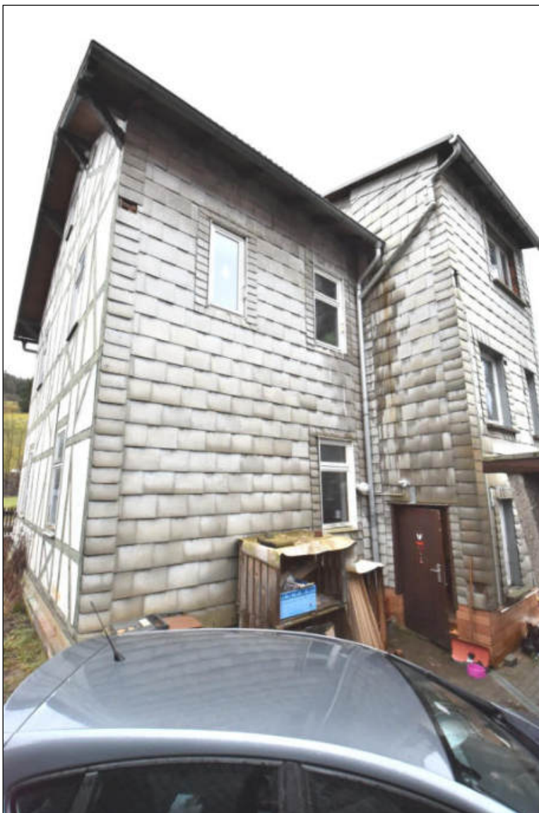
Gebäudehinterseite mit Asbestfassade und Nebengebäude (links) Nordwestansicht
