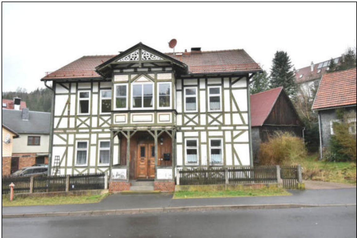
Straßenseite mit Eingang, Südostansicht
