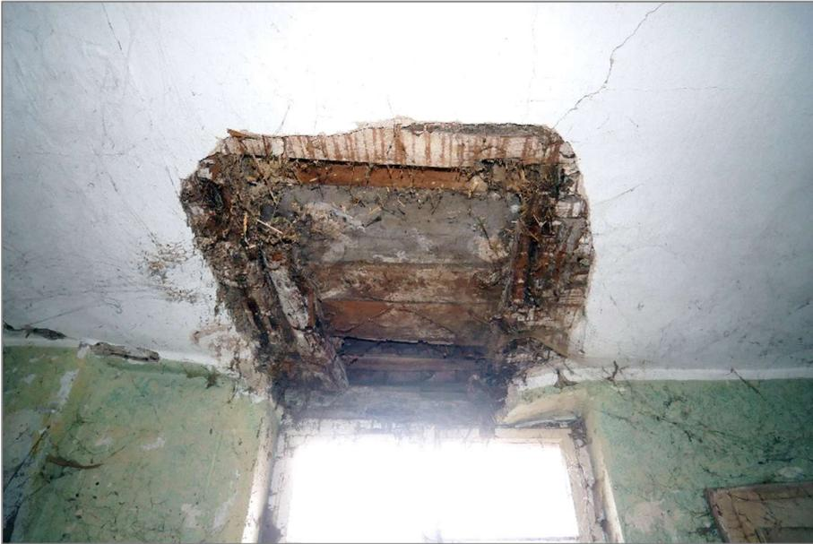
Foto 9 - Lagergebäude - schadhafte Erdgeschossdecke
