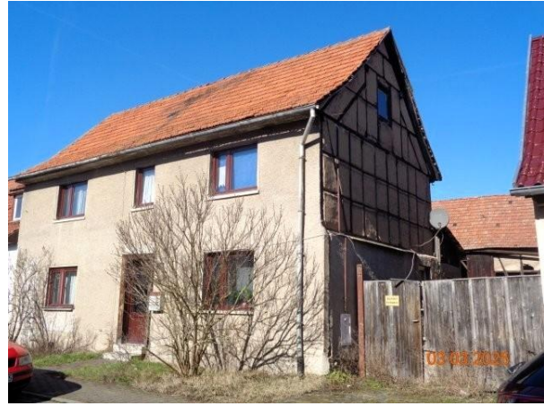
Bild 10: Süd-Ost-Ansicht Wohngebäude Backhausstraße 35
