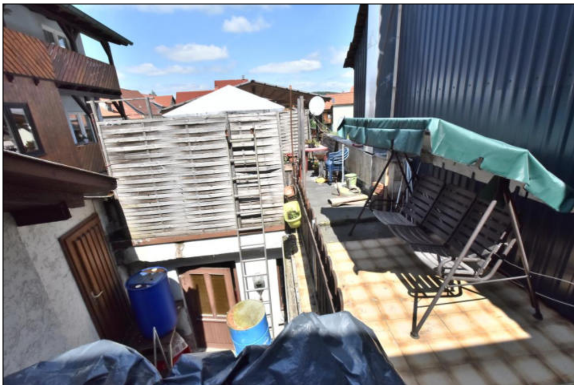
1. Obergeschoss, Terrasse mit Blick zur darunterliegenden Lagertür
