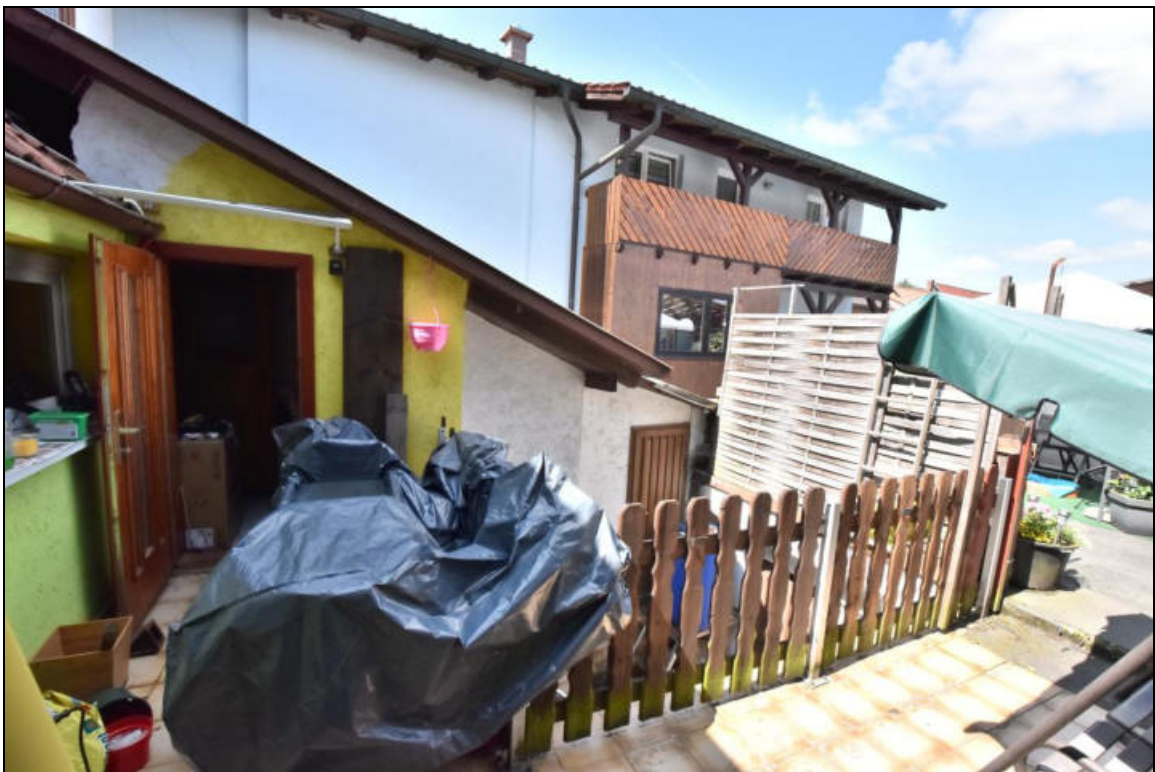
Nordostansicht mit Terrassentür (links, ehem. Bad / WC)
