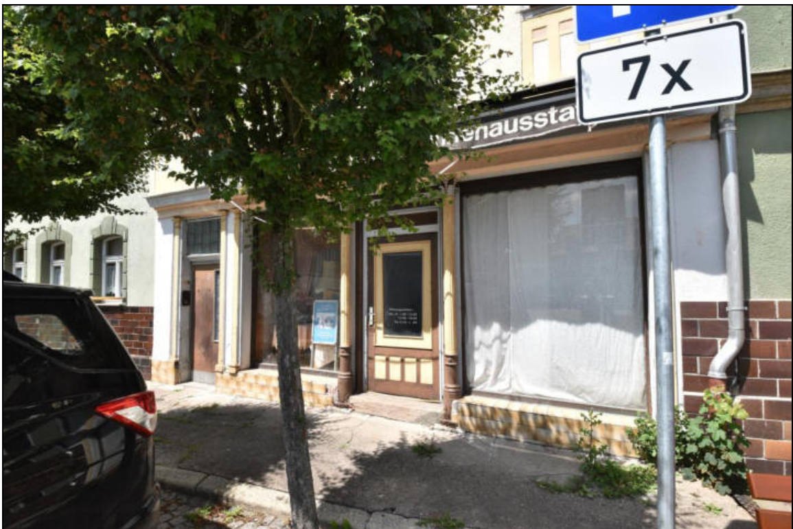
Erdgeschossbereich mit ehem. Laden und Haustür (links) Ostansicht
