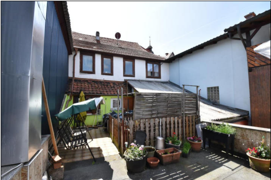
Wohn- und Geschäftshaus Hinterseite, Ebene 1 Obergeschoss mit anliegendem Terrassendach, Nordansicht
