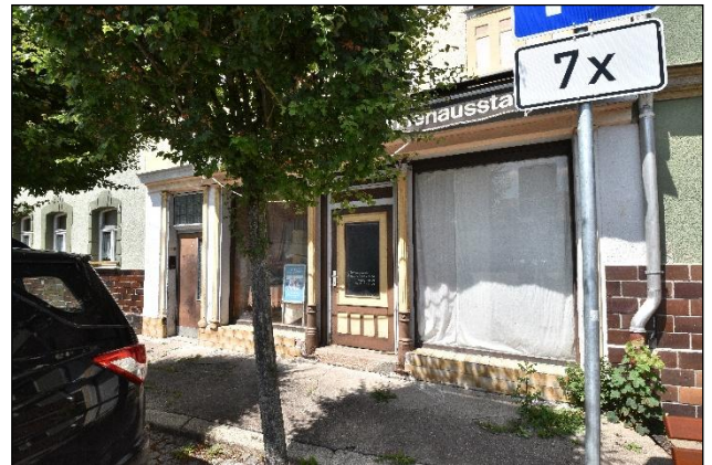
Erdgeschossbereich mit ehem. Laden und Haustür (links), Ostansicht
