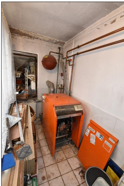
Heizungsraum mit Fenster zum Lager
