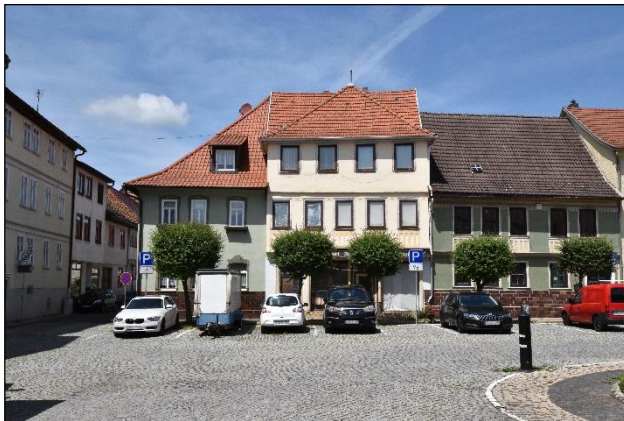
Wohn- und Geschäftshaus (Gebäude Bildmitte), Lage und Erschließungssituation, Südostansicht
