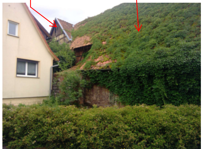
Blick von der Gemeindestraße in südliche Richtung
