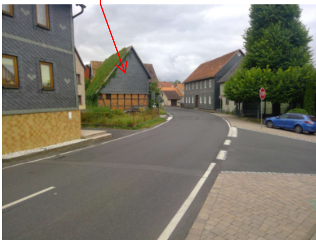
Blick von der Landstraße in südöstliche Richtung
