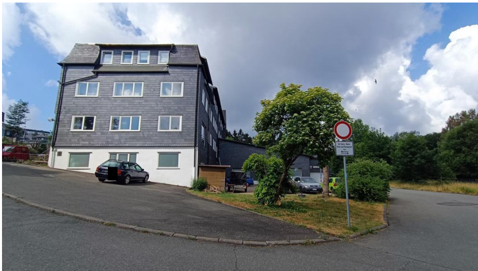
Nordostansicht Hotel und Hotelanbau
