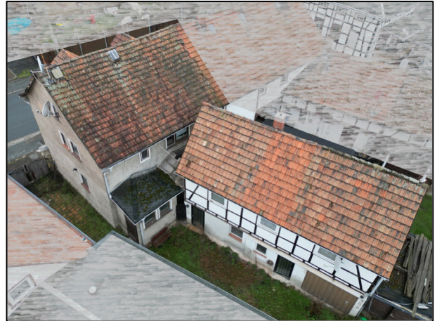
Doppelhaushälfte u. Nebengebäude 1 (Stallgebäude) Rück-/Hofansicht von oben (Nord-Ost-Ansicht)
