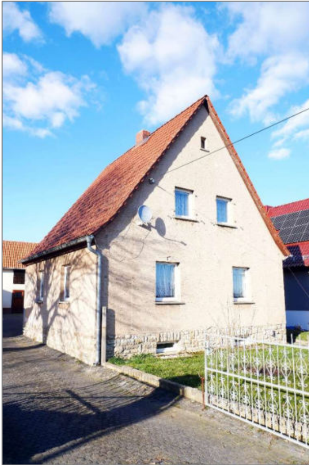
Foto 1 - Wohnhaus - Straßenansicht (Südansicht)
