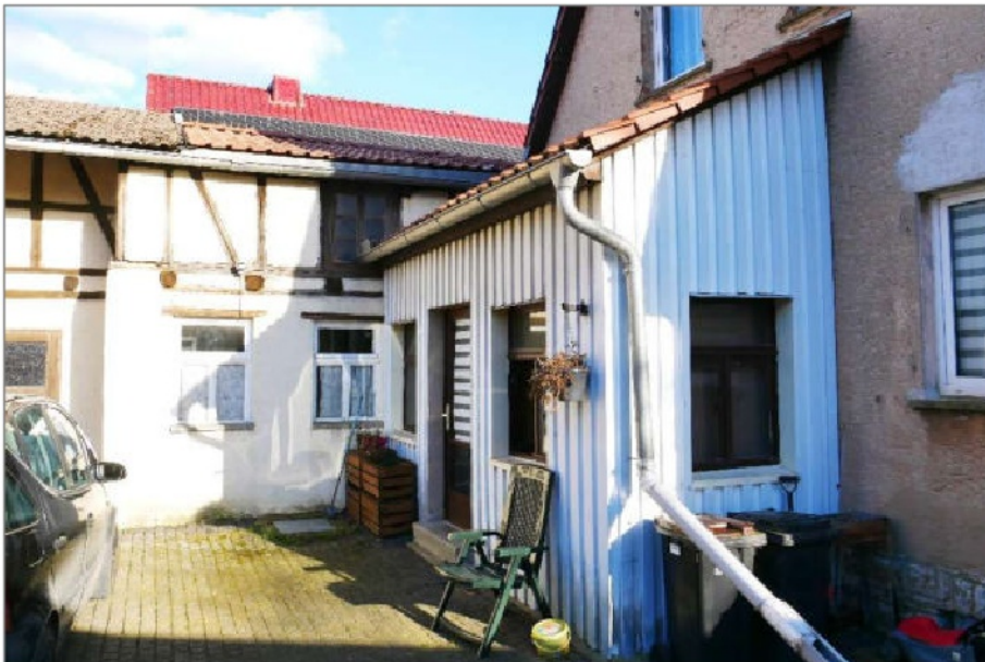
Foto 4 - Veranda und Waschküchenanbau - Westansicht
