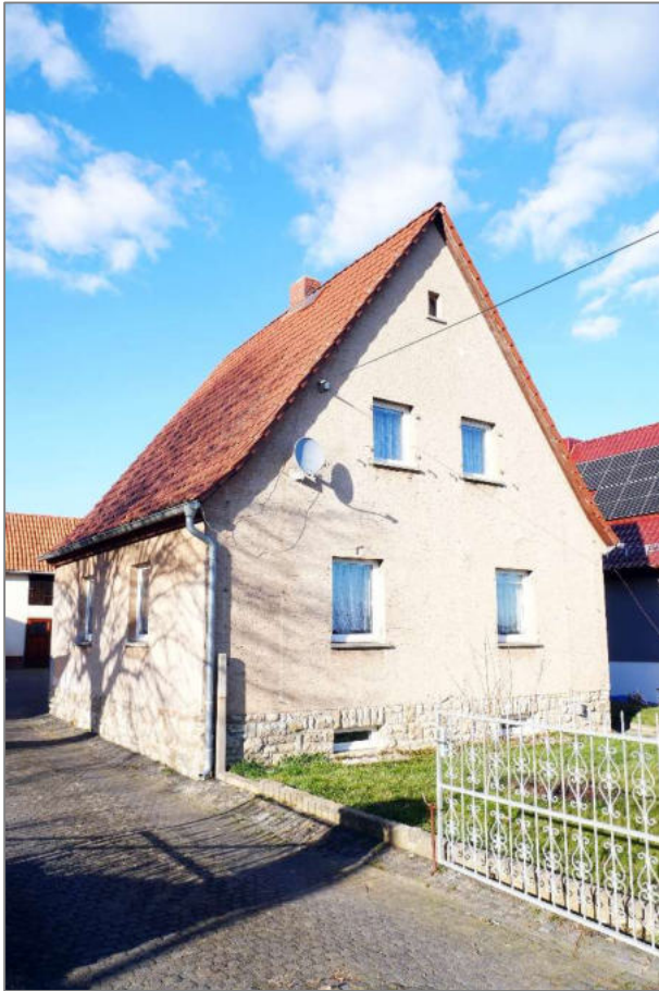
Foto 1 - Wohnhaus - Straßenansicht (Südansicht)
