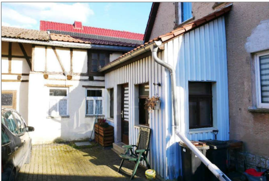
Foto 4 - Veranda und Waschküchenanbau - Westansicht
