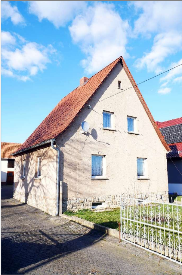
Wohnhaus - Straßenansicht (Südansicht)
