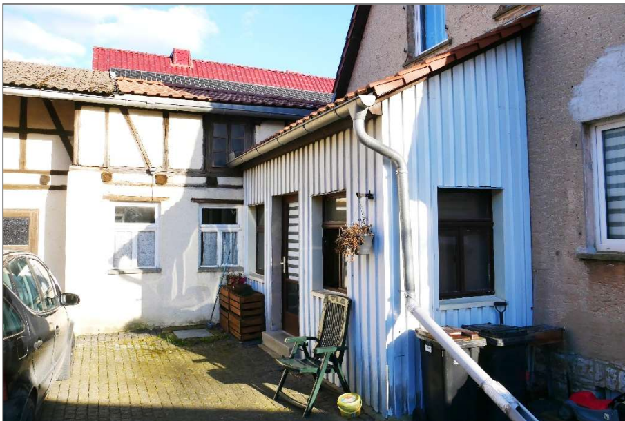
Veranda und Waschküchenanbau - Westansicht
