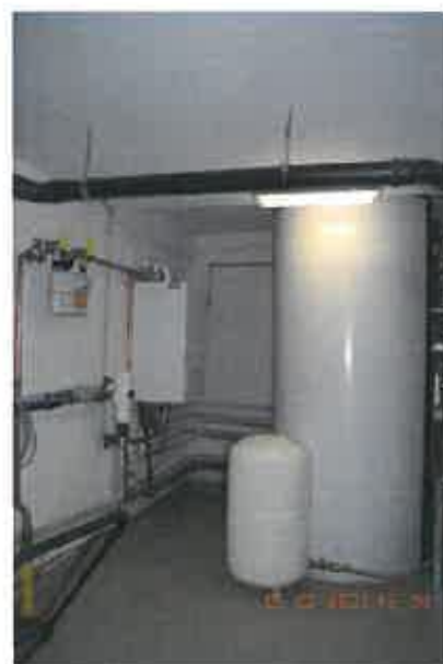
Gastherme, Pufferspeicher
