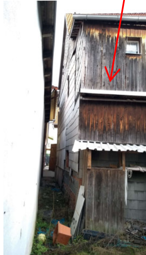
Durchgang, Blick vom Hof
