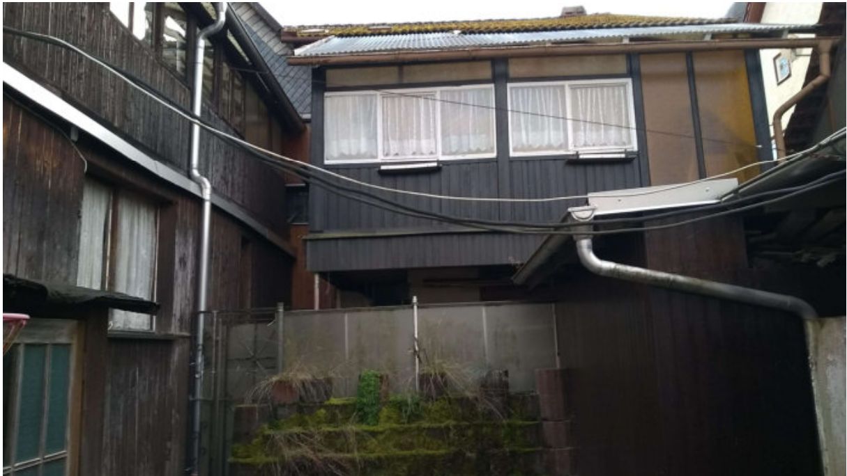
Blick vom Hof in südliche Richtung
