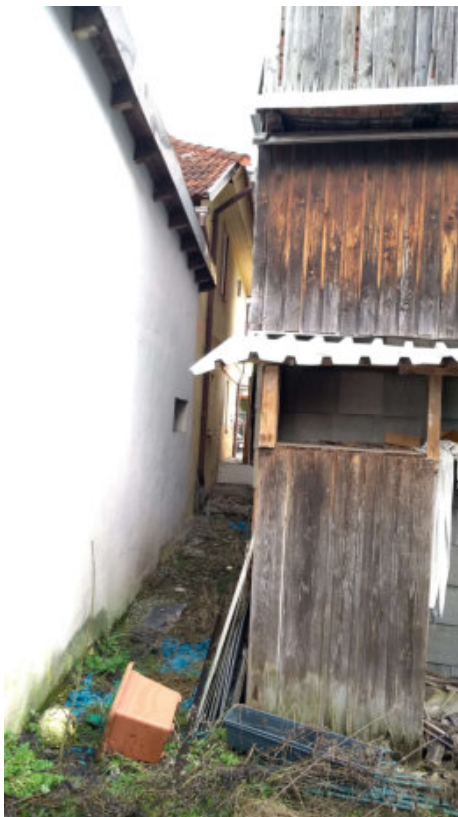
Durchgang, Blick vom Hof
