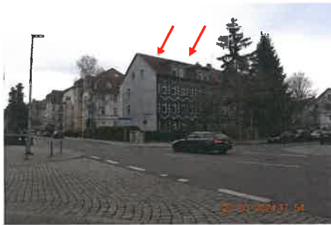
straßenseitige Ansicht Eckbereich Brühlerwallstraße/Bonifaciusstraße
