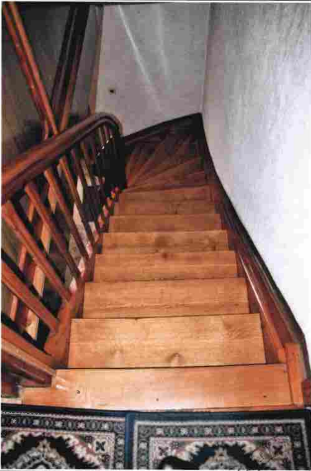
Wohnhaus Treppe zum Obergeschoss
