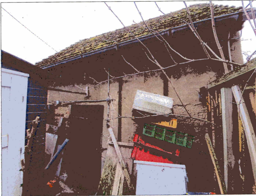
Blick aus Richtung Nordwesten auf das Nebengebäude
