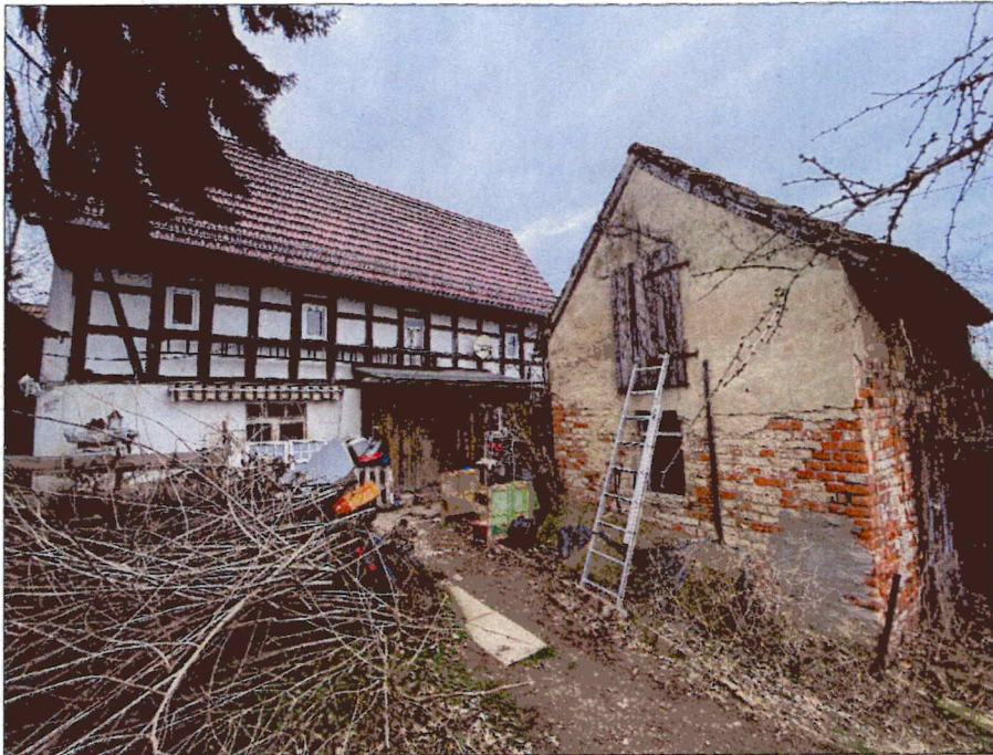
Gebäuderückfront des Wohnhauses und Nebengebäude, Ansicht aus Richtung Südwesten
