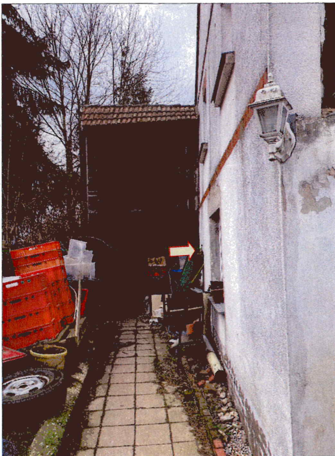
Blick aus Richtung Süden auf den seitlichen Anbau, ⇒ Zugang zum Lagerraum des Wohnhauses von außen
