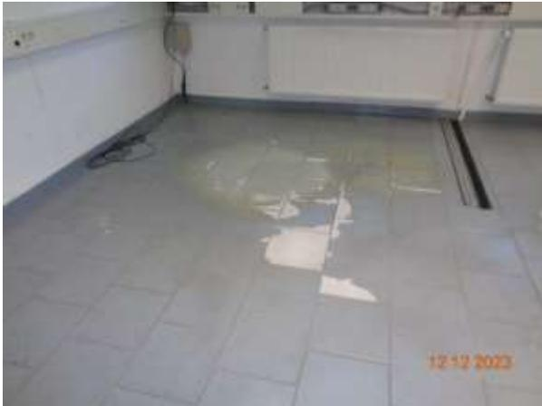
Bild 25: Fliesenbelag im Erdgeschoss partiell mit Oberflächenschäden
