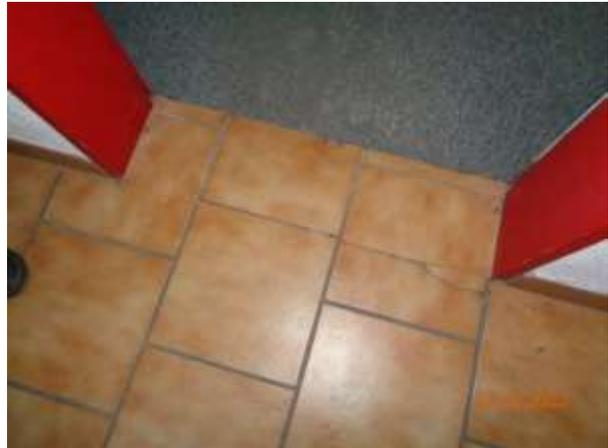
Bild 18: Flurbereich im Erdgeschoss innen; Fliesen schadhaft/
