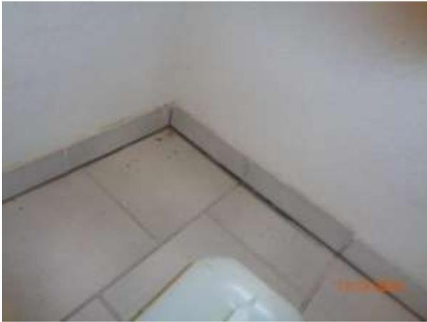
Bild 21: partieller Fugenabriss (teilweise bis 20 mm) Fußbodenfliesen zur Sockelkante in mehreren Bereichen im Erdgeschoss
