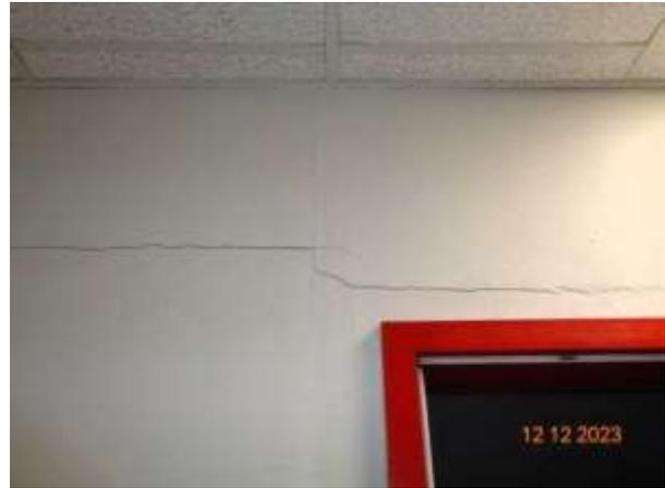
Bild 30: starke Rissbildung an tragender Innenwand im Obergeschoss des zweigeschossigen Büroanbaus
