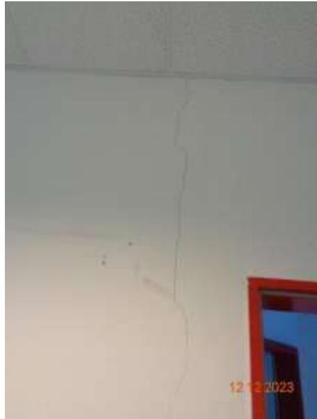
Bild 26: Vertikalriss an tragender Innenwand im Erdgeschoss
