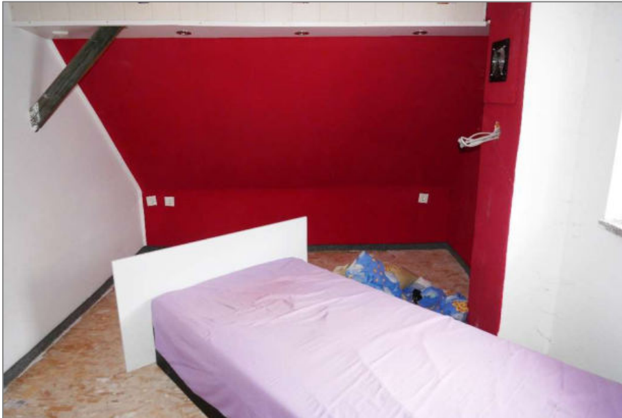
Foto 14 - Wohnhaus - Kinderzimmer DG
