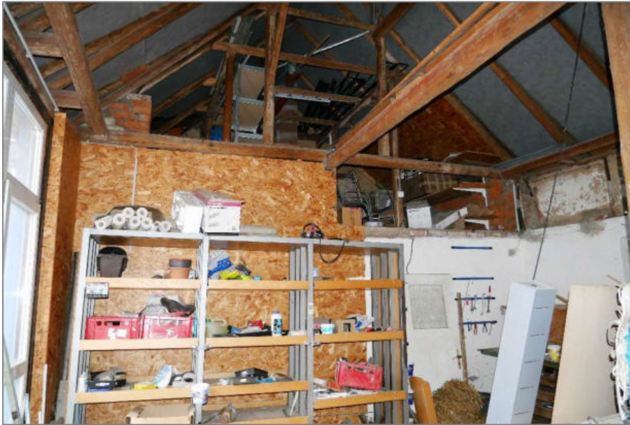
Foto 18 - Nebengebäude - Innenansicht ehem. Scheune
