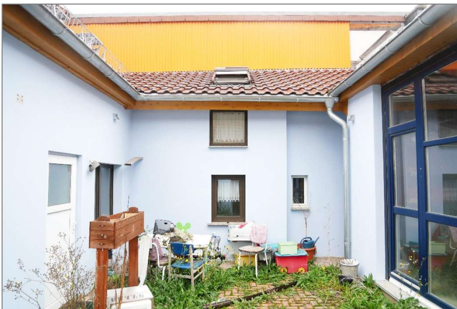
ostseitiger Anbau am Wohnhaus - Hofansicht
