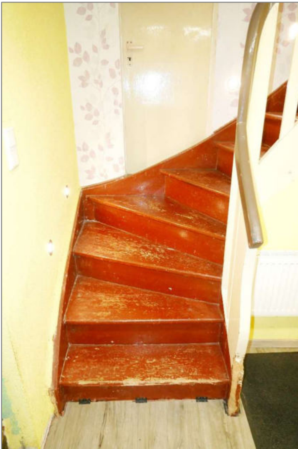
Foto 6 - Wohnhaus - Treppe vom EG zum DG
