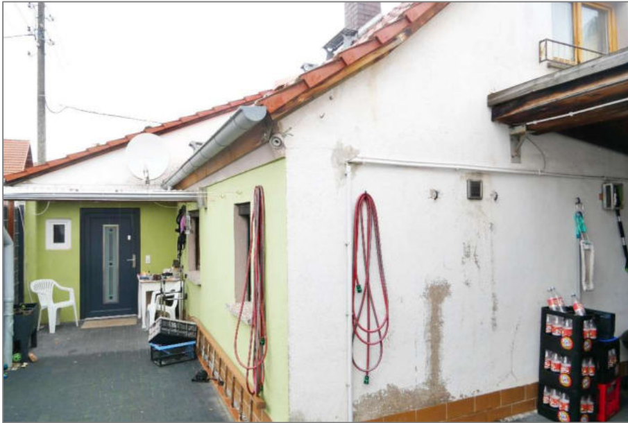
Foto 3 - Wohnhaus - Südsansicht (Hofansicht)
