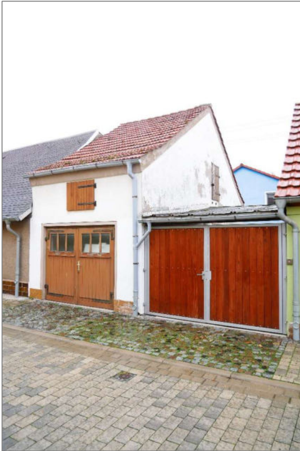
Foto 15 - Nebengebäude / Garage - Nordostansicht
