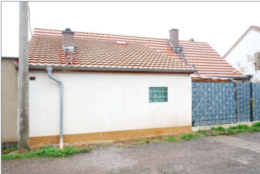
Foto 2 - Wohnhaus mit Anbau - Westansicht
