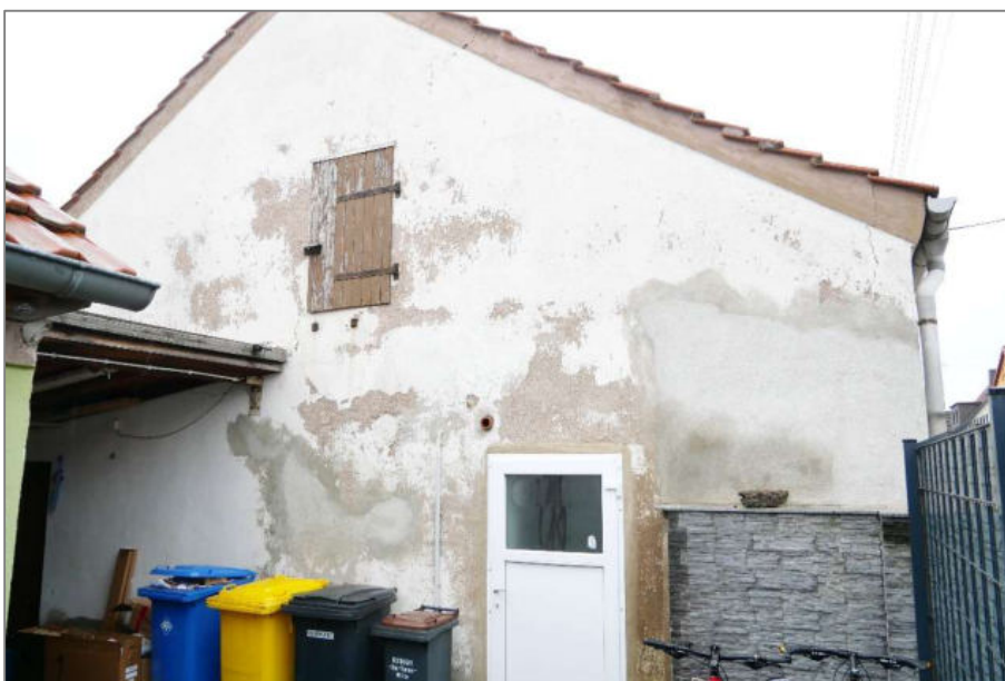
Foto 16 - Nebengebäude / Garage - Nordansicht (Hofansicht)
