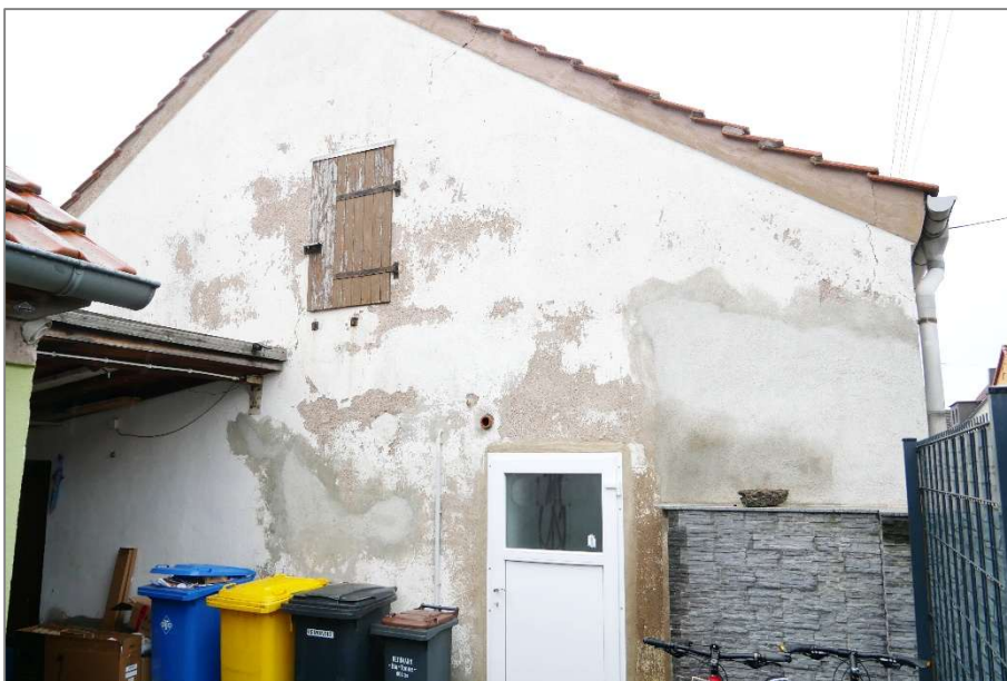
Nebengebäude / Garage - Nordansicht (Hofansicht)
