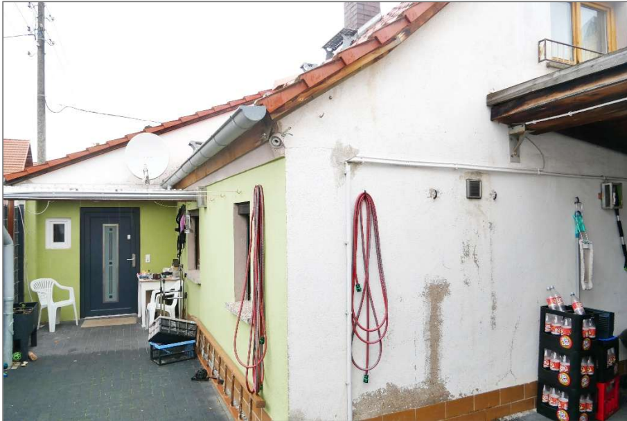
Wohnhaus - Südansicht (Hofansicht)
