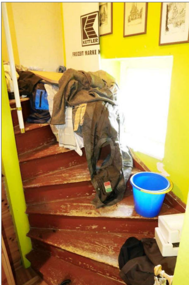
Foto 11 - Wohnhaus - Treppe vom EG zum DG
