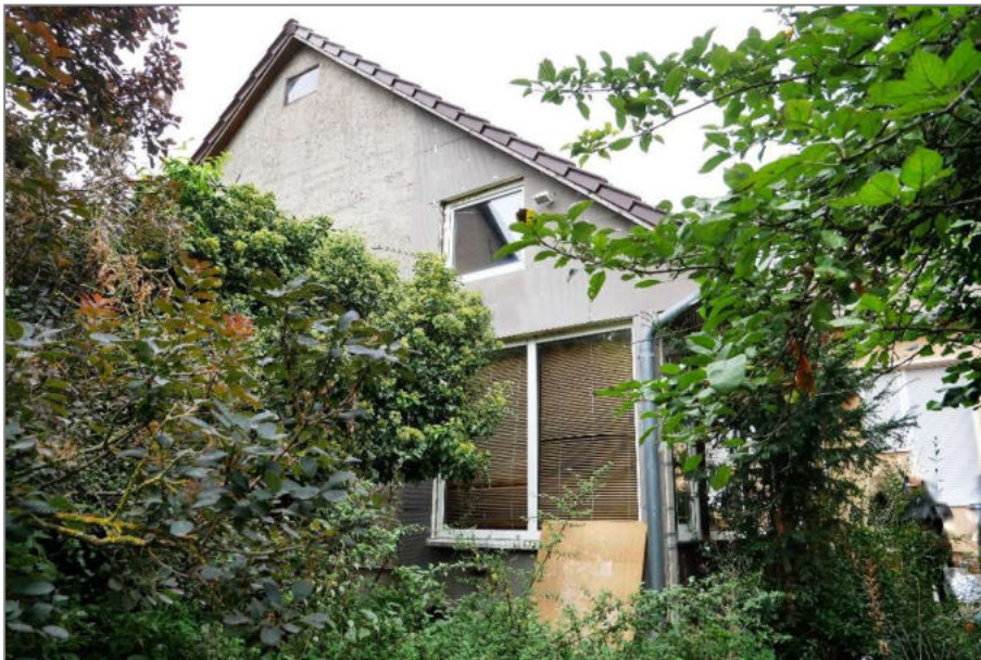
Foto 6 - Wohnhaus - westseitiger Anbau - Westansicht
