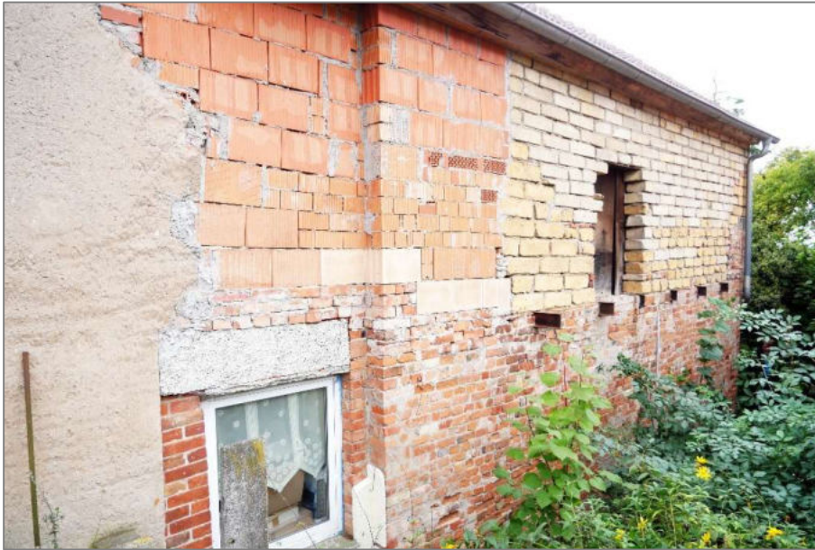
Foto 5 - Wohnhaus - westseitiger Anbau - Nordansicht
