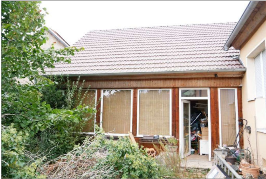
Foto 1 - Wohnhaus - westseitiger Anbau - Südansicht
