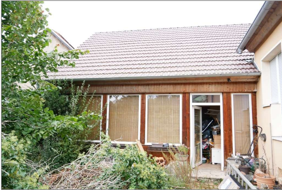
Wohnhaus - westseitiger Anbau - Südsicht
