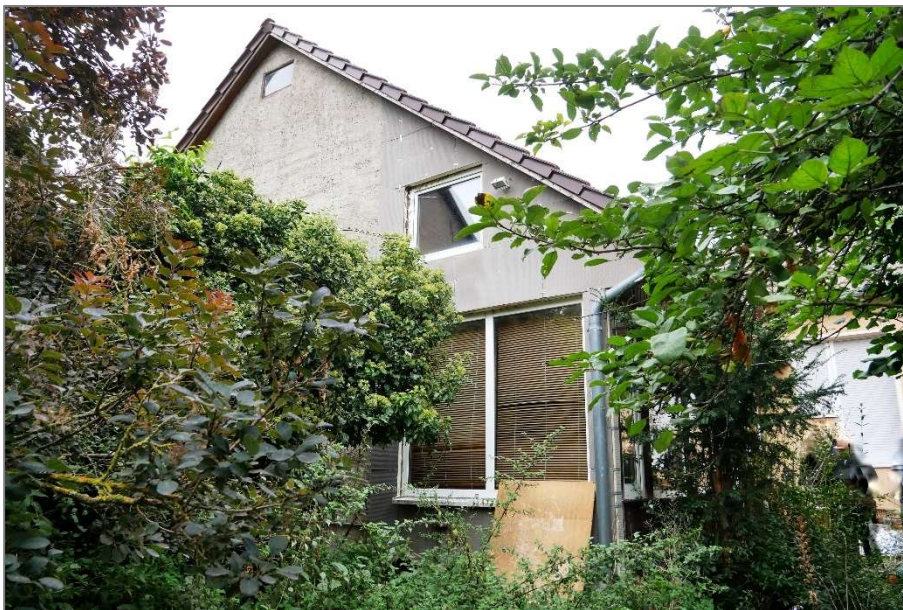
Wohnhaus - westseitiger Anbau - Westansicht
