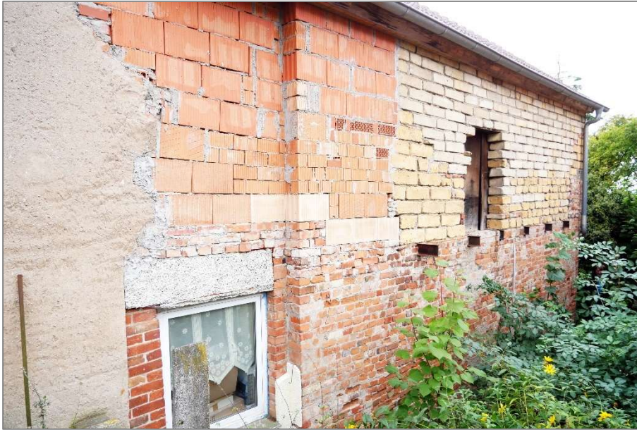
Wohnhaus - westseitiger Anbau - Nordansicht
