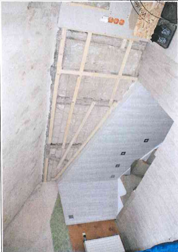
Flurstück 73 Wohnhaus Dachgeschoss Treppenraum
