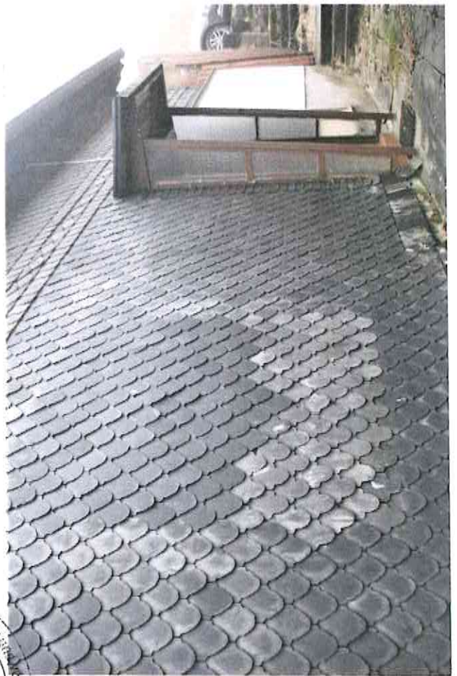
Flurstück 73 Nordostansicht Wohnhaus, Zugang
