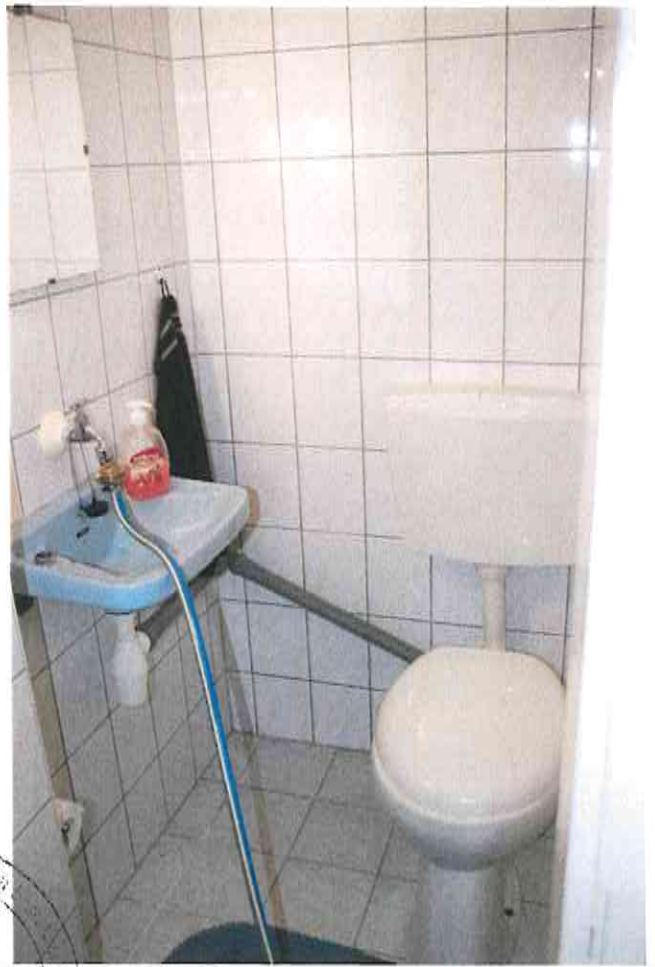
Flurstück 73 Wohnhaus Erdgeschoss WC
