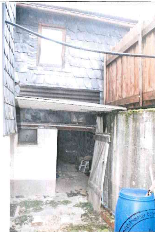
Flurstück 73 Südwestansicht Anbau
