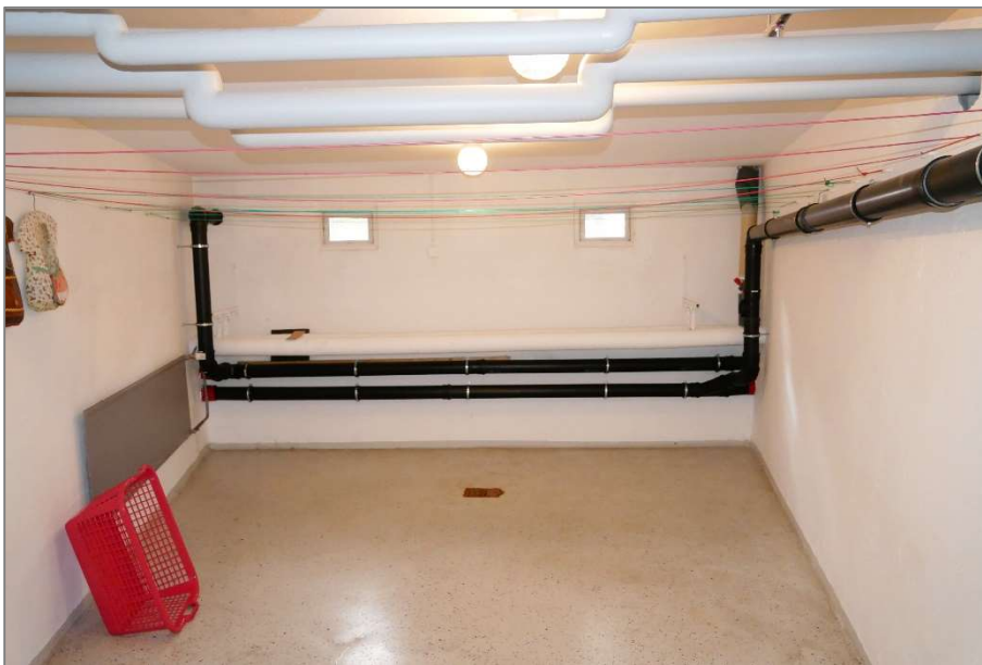
60 WE-Wohngebäude - Gemeinschaftsraum (Trockenraum KG)
