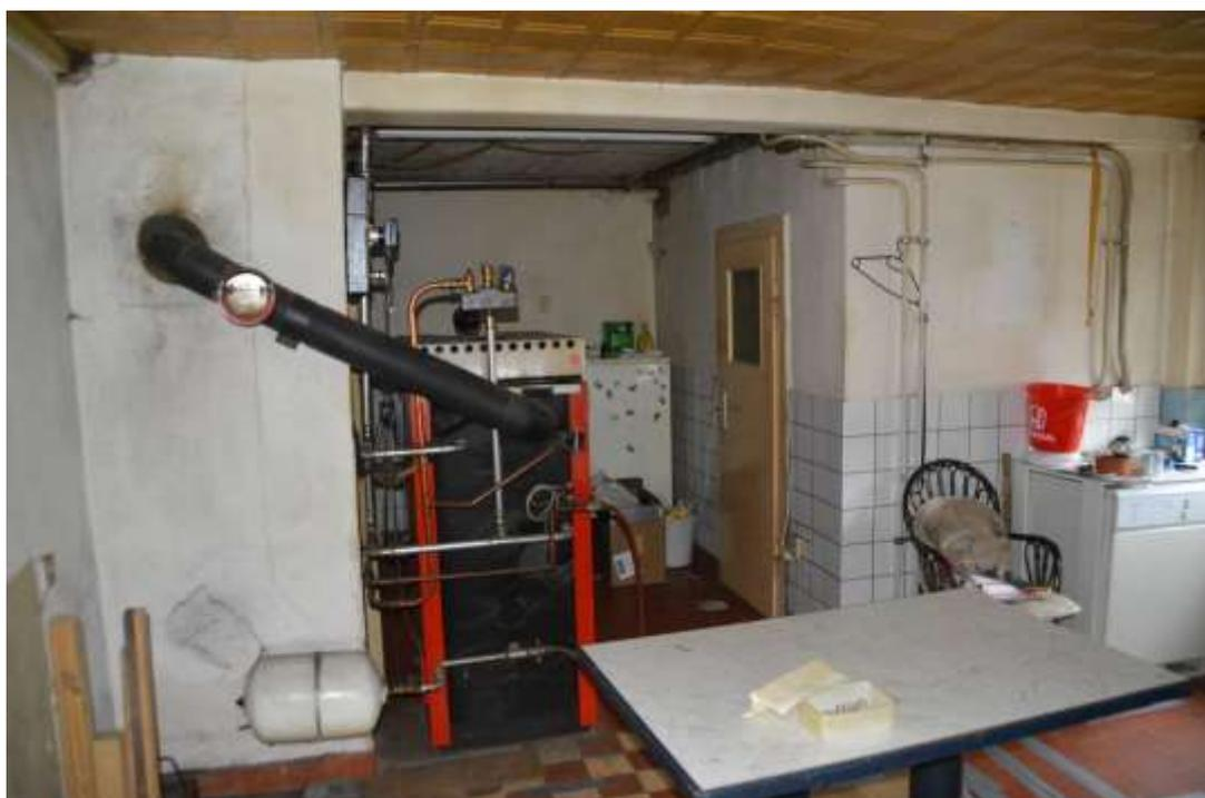
Bild 11 (oben): Waschküche EG mit Pufferspeicher für Holzheizung
