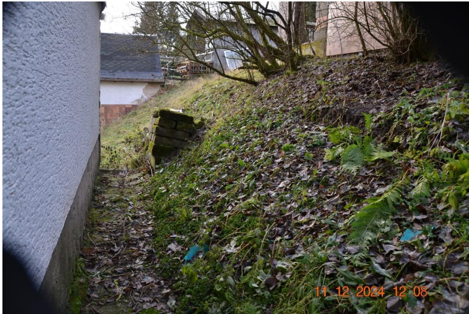
13: kleiner Grundstücksstreifen hinter dem Gebäude
