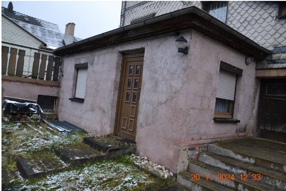
3: Straßenseitiger Anbau mit Eingang
