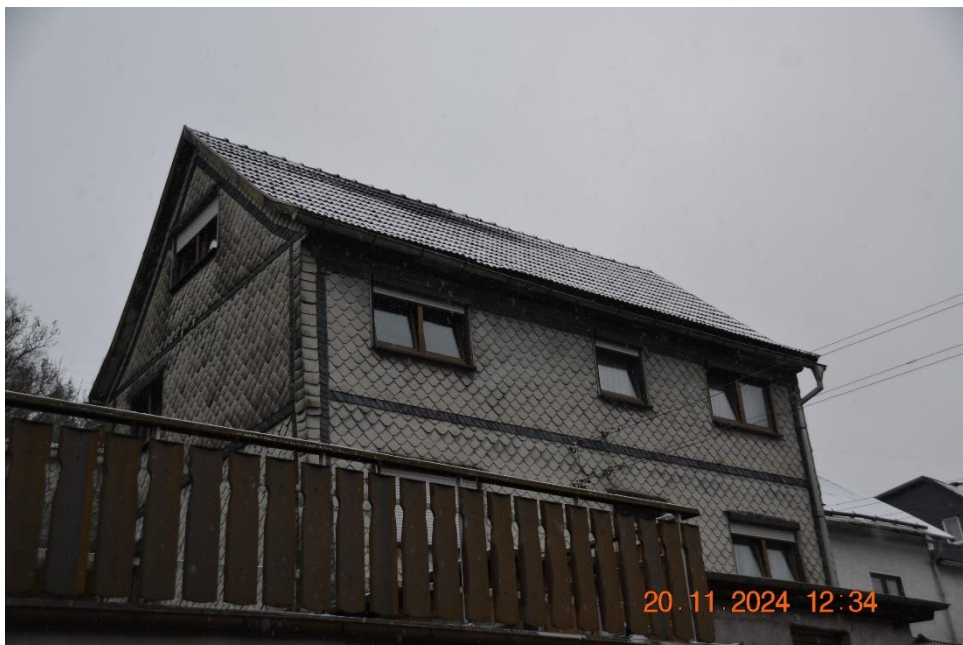
4: Straßenansicht aus südöstlicher Richtung
