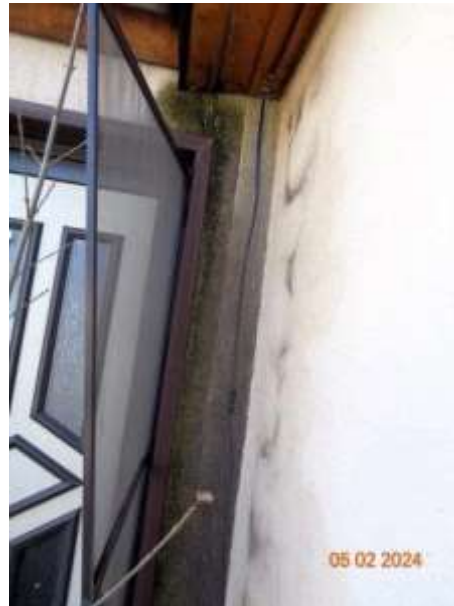
Bild 8: wie Bild 7; Ansicht von außen (Anschlussbereich zwischen Wohnhaus und Wohnhausanbau)
