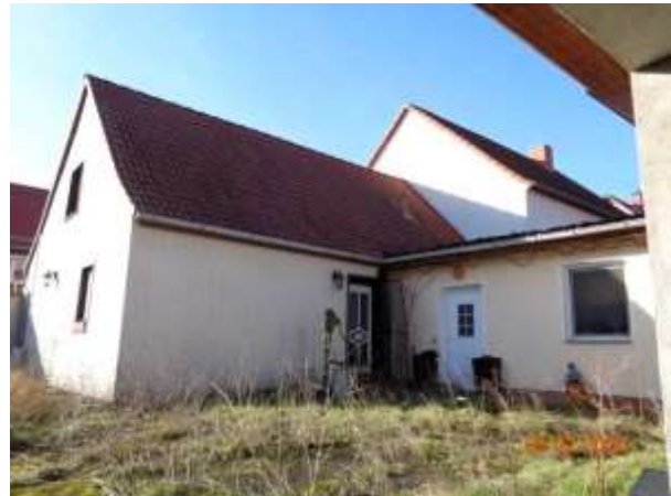
Bild 4: hofseitige Ostansicht des Wohnhauses mit hofseitigem Anbau
