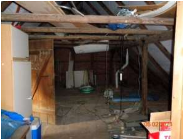
Bild 15: nicht ausgebautes Dachgeschoss
