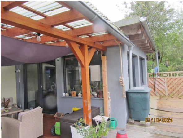
Terrasse mit Über- bau vom Wohnhaus auf Flurstück 300 (Nordansicht)
