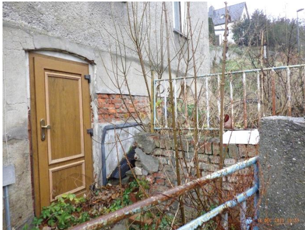
Eingang zum Keller an der Gebäudesüdseite
