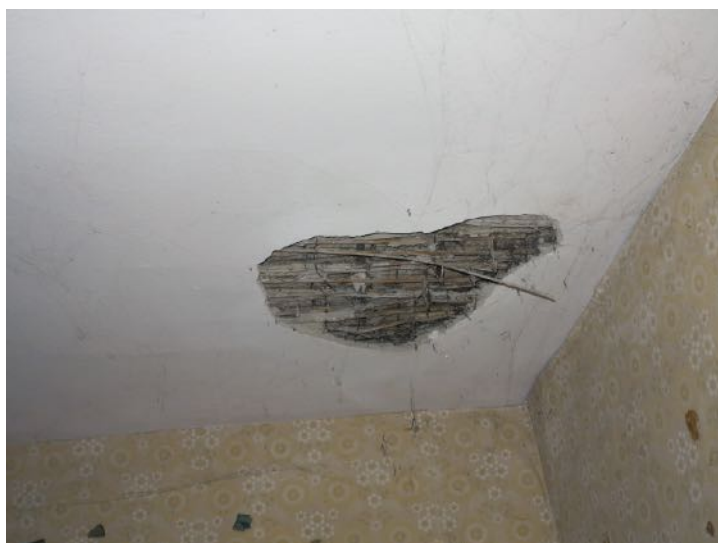
OG Schaden an Decke
