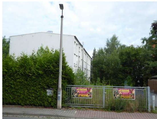
Zufahrt und Blick von der Sommeritzer Straße
