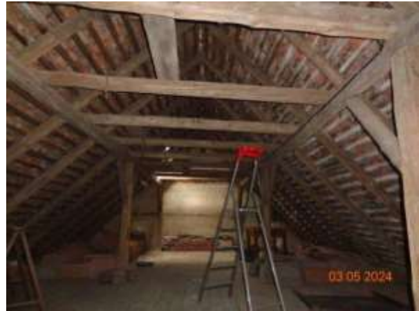
Bild 18: nicht ausgebautes Dachgeschoss im westlichen Gebäudeteil des Wohnhauses
