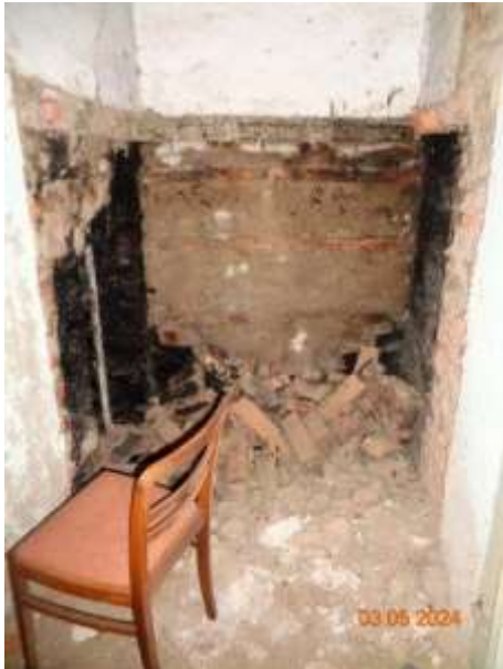
Bild 9: Vorraum/Flur im separaten westlichen Gebäudebereich im Erdgeschoss des Wohnhauses
