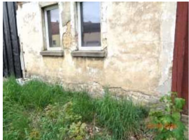
Bild 4: Ansicht nordseitiger Erdgeschossbereich des östlichen Wohngebäudeteils
