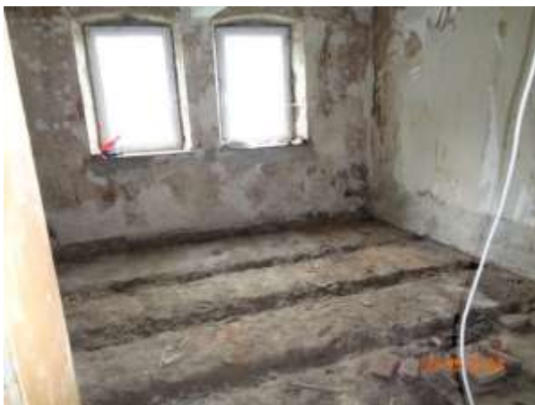
Bild 11: Wohnraum straßenseitig im östlichen Gebäudebereich im Erdgeschoss des Wohnhauses
