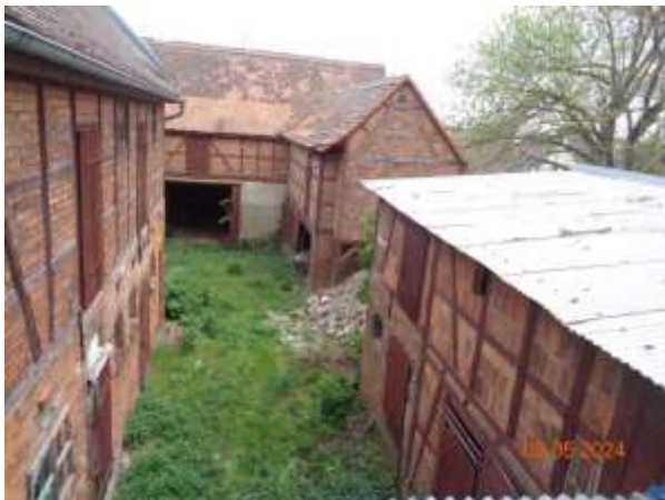
Bild 19: Blick vom Wohnhaus in den südlichen Innenhofbereich auf die Nebengebäude
