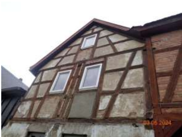
Bild 3: Ansicht nordseitiger Giebel des östlichen Wohngebäudeteils
