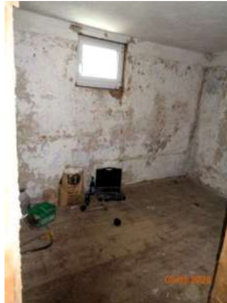
Bild 14: Nebenraum im östlichen Gebäudebereich im Obergeschoss des Wohnhauses
