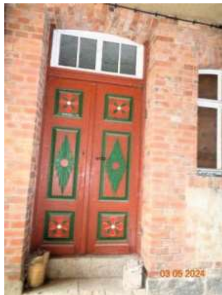
Bild 8: Zugang zum separaten westlichen Gebäudebereich im Erdgeschoss des Wohnhauses
