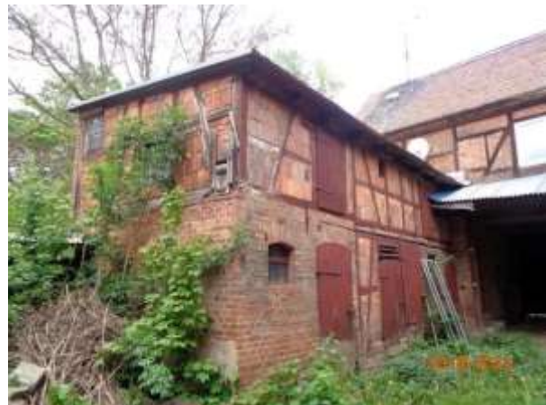
Bild 20: ehemalige Waschküche; südseitig an den westlichen Gebäudeteil des Wohnhauses angebaut
