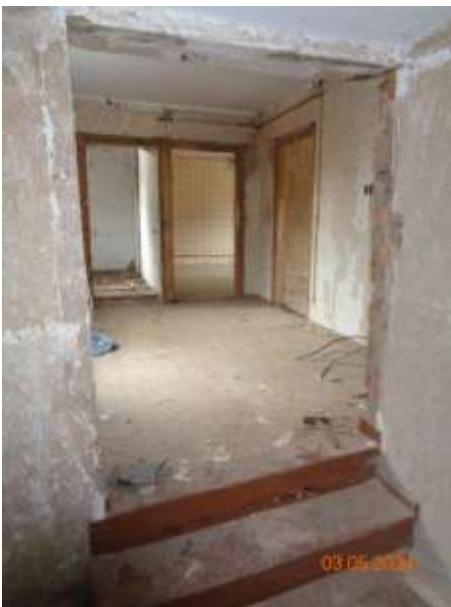
Bild 15: Übergang vom östlichen zum westlichen Gebäudebereich im Obergeschoss des Wohnhauses (über Wagentdurchfahrt)
