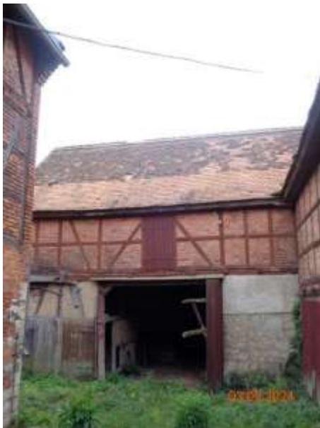
Bild 31: Scheunengebäude mit Wagendurchfahrt
