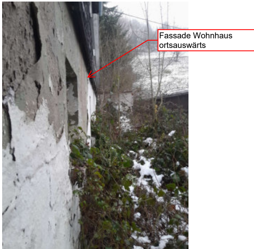
Blick vom Bewertungsgrundstück in östliche Richtung
