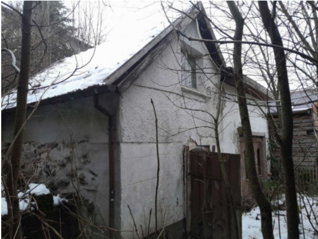
Blick vom Bewertungsgrundstück in nordwestliche Richtung
