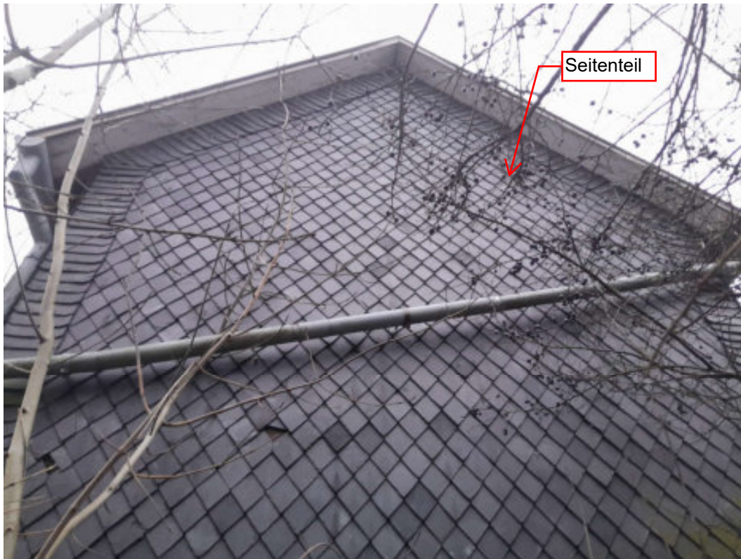
Blick vom Bewertungsgrundstück auf die Westseite des Wohnhauses
