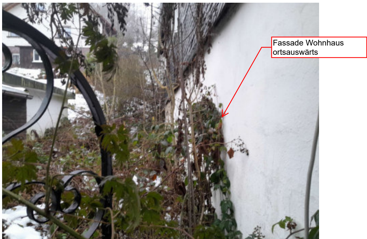
Blick vom Bewertungsgrundstück in westliche Richtung
