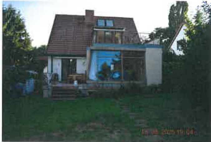
rückwärtige Gebäudeansicht mit Wintergarten/Terrasse
