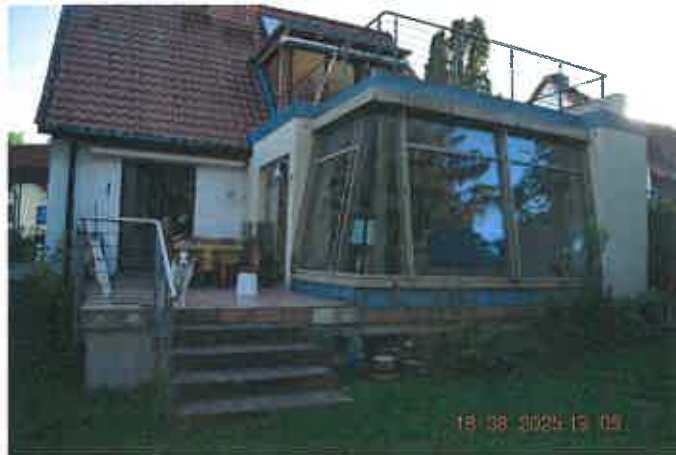
rückwärtige Terrasse mit Wintergarten
