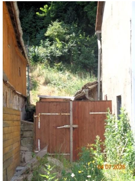
Bild 10: zweiflügeliges Holztor grundstückssüdseitig mit dahinterliegendem ansteigenden, bewaldetem Hang
