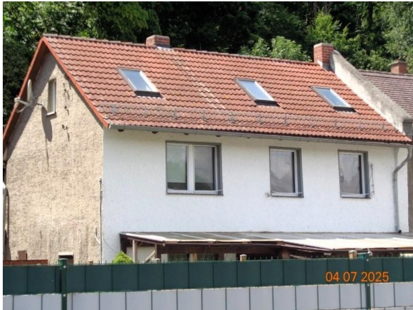
Bild 5: Südostansicht Obergeschoss und Dachgeschoss des Wohnhauses
