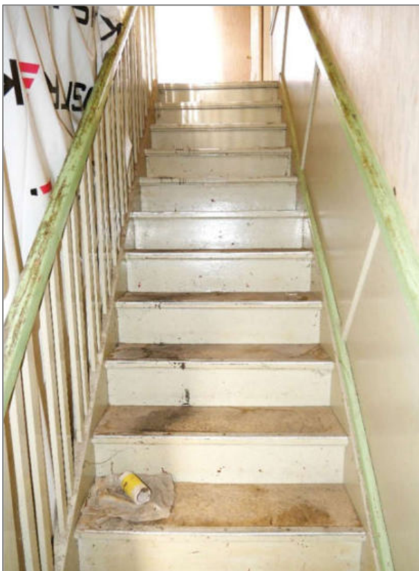
Foto 11 - Wohnhaus - Treppe vom EG zum OG
