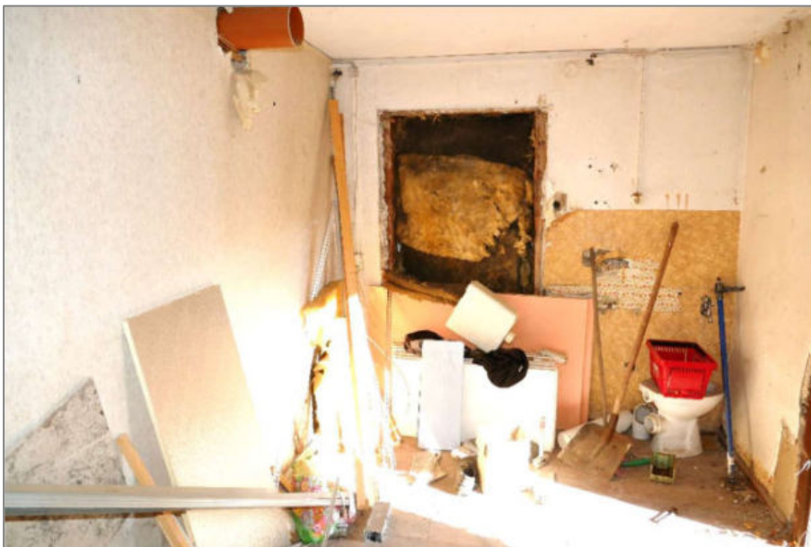
Foto 13 - Wohnhaus - Zimmer EG (nur mit rückseitigem Zugang)
