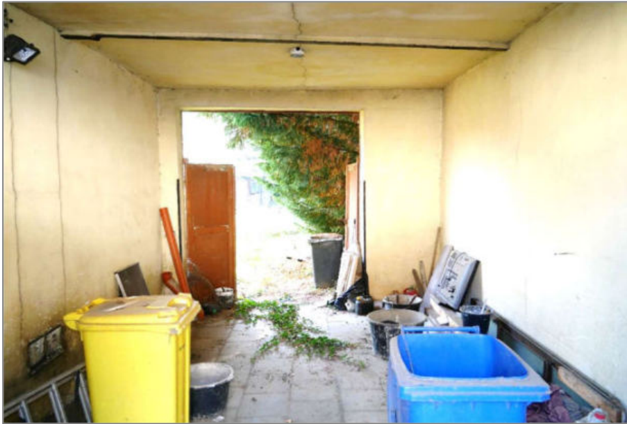
Foto 12 - Wohnhaus - überbaute Torfahrt EG
