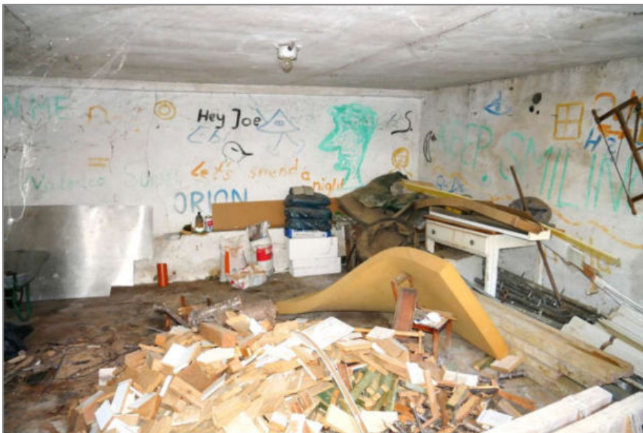
Foto 25 - Garage / Schuppen - Innenansicht
