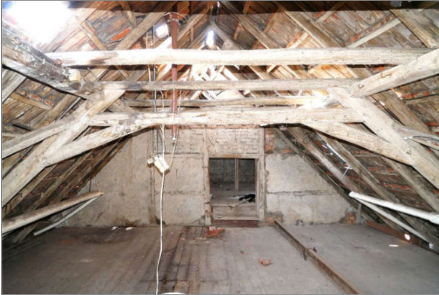
Foto 18 - Wohnhaus - nicht ausgebauter Dachboden
