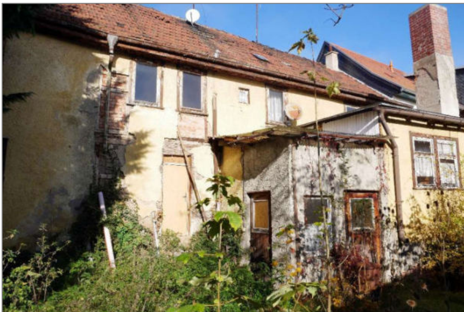
Foto 2 - Wohnhaus - Südansicht (Hofansicht)
