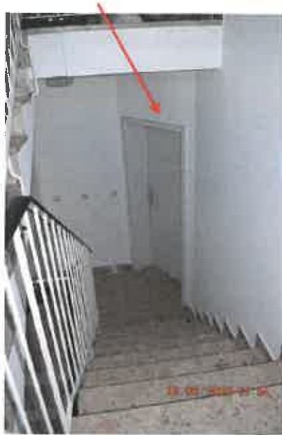
Treppenhaus mit Wohnungseingang
