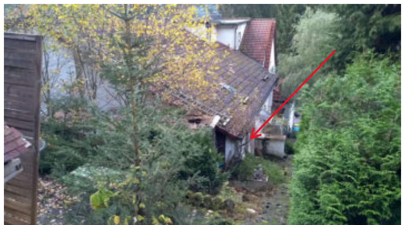
Außeneingang zu der zu bewertenden Wohnung
