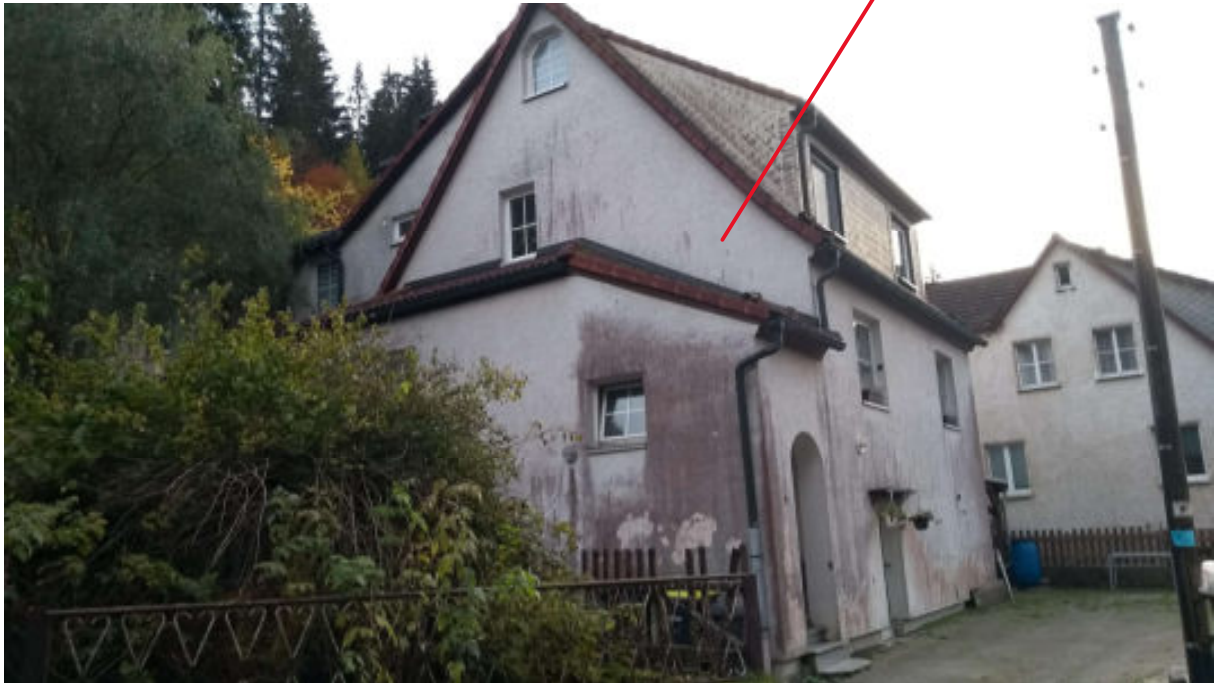
Ansicht von der Grundstückszufahrt aus nördlicher Richtung
