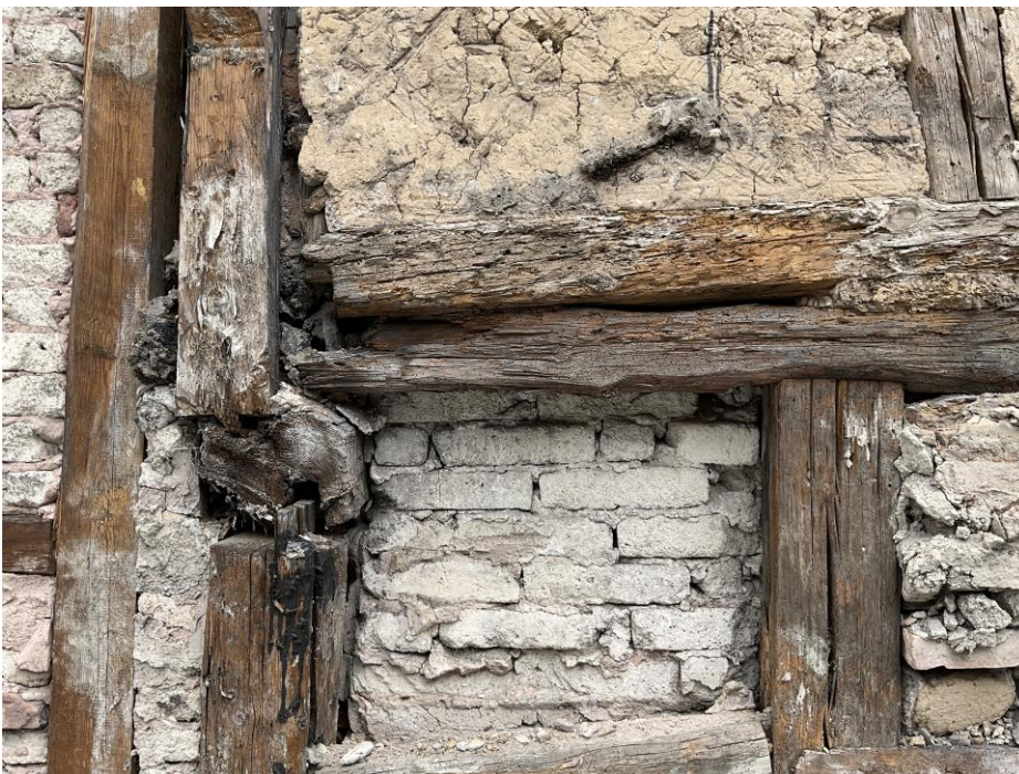
Bauschäden Fachwerk
