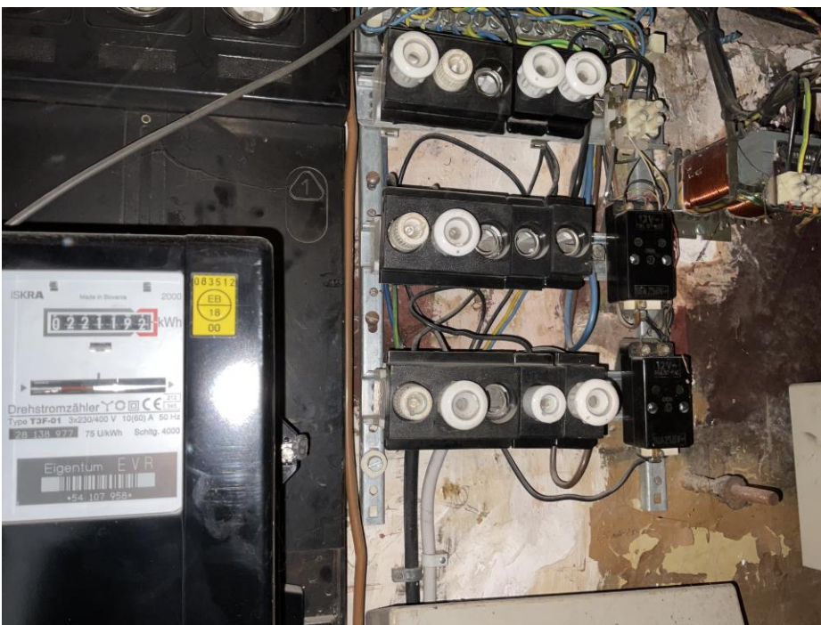
Elektroanlage überaltert
