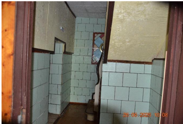
Eingangsbereich im Keller
