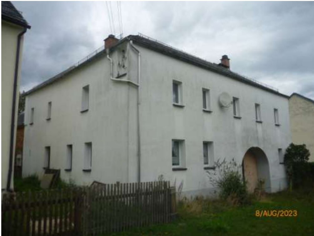
Bild 1: Südwestansicht des Beschlagnahmeobjektes von der Ortsstraße; die Zufahrt ist hier aufgrund der eingeschränkten Durchfahrtsbreite nur bedingt möglich
