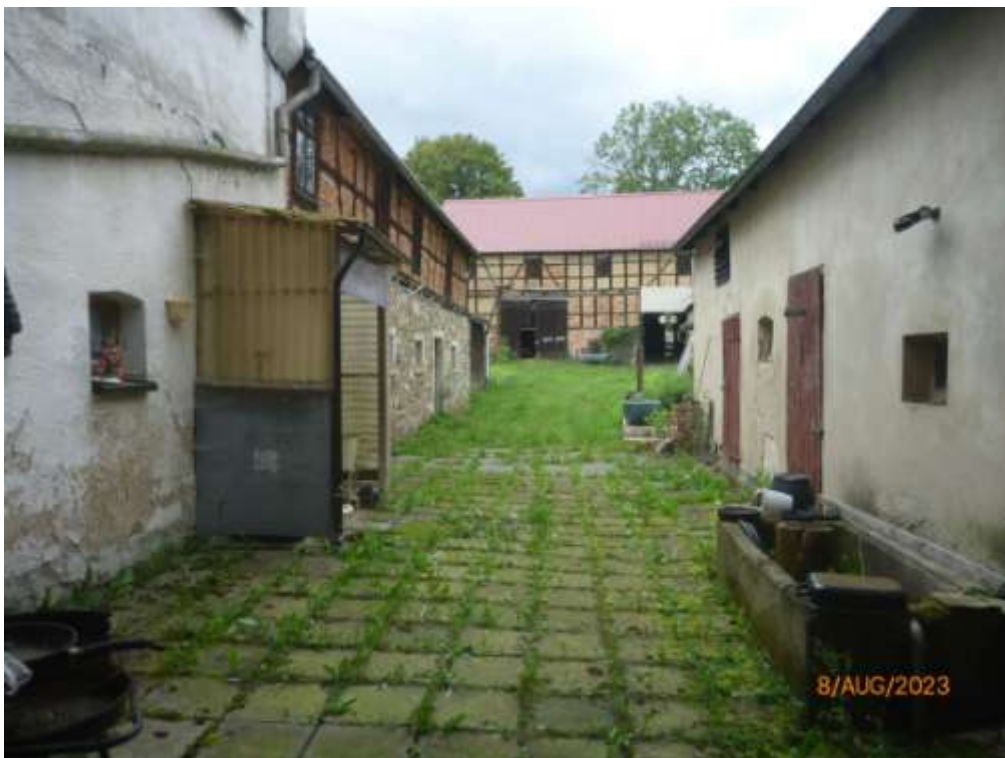
Bild 2: Blick von der Tordurchfahrt unter dem Wohnhaus in den Innenhof; links der Wohnhauseingang und die angrenzende Bebauung mit Stall und Garage dahinter, rechts das Nebengebäude, hinten die Scheune
