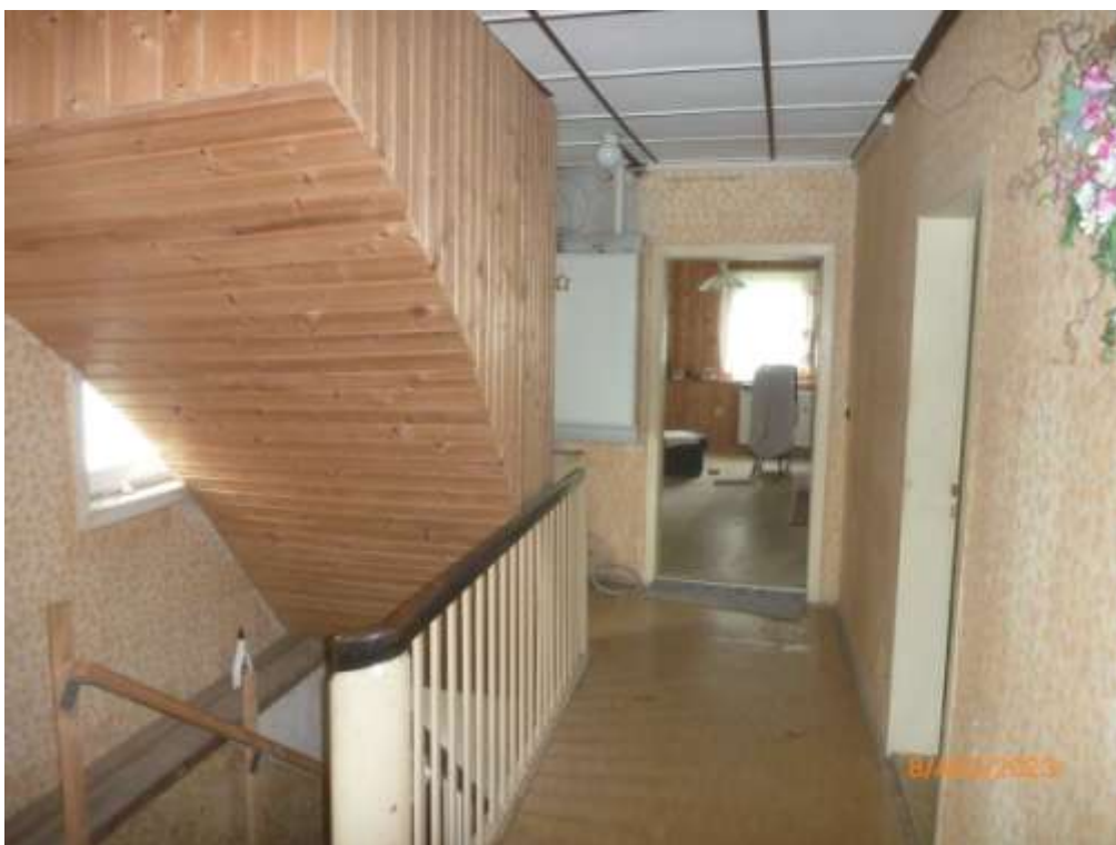
Bild 8: Treppenhaus/Flur im Obergeschoss mit eingebaute Treppe zum Dachboden
