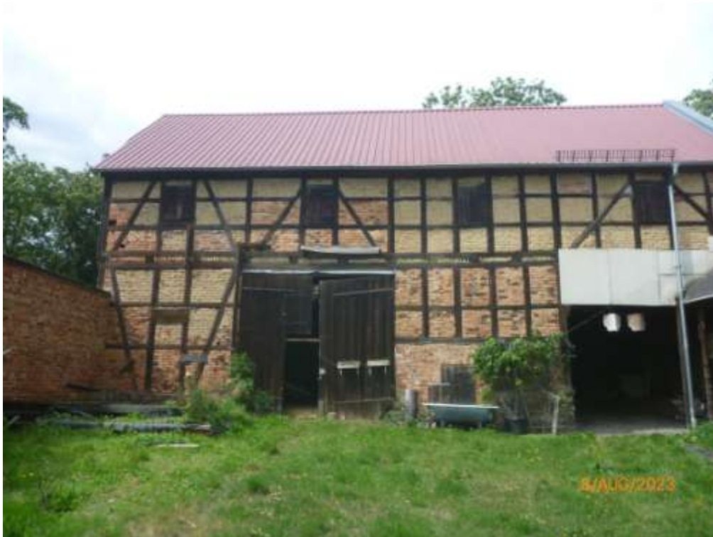
Bild 17: Südansicht der Scheune vom Innenhof; rechts die Scheunendurchfahrt
