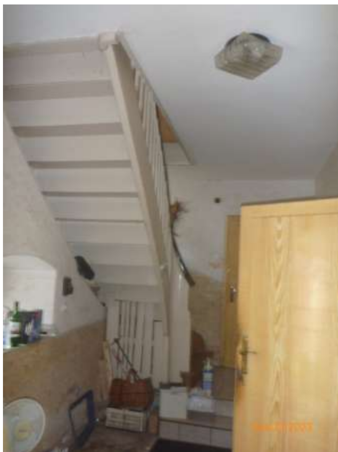
Bild 4: Flur im Wohnhauserdgeschoss mit Zugang zu Küche und Wohnzimmer, sowie Treppe zum Obergeschoss
