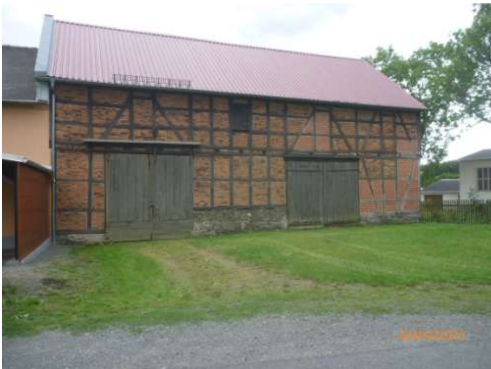
Bild 18: Ansicht der Scheune von der nördlich vorbeiführenden Ortsstraße; die Grünfläche im Vordergrund gehört noch zum Beschlagnahmeobjekt
