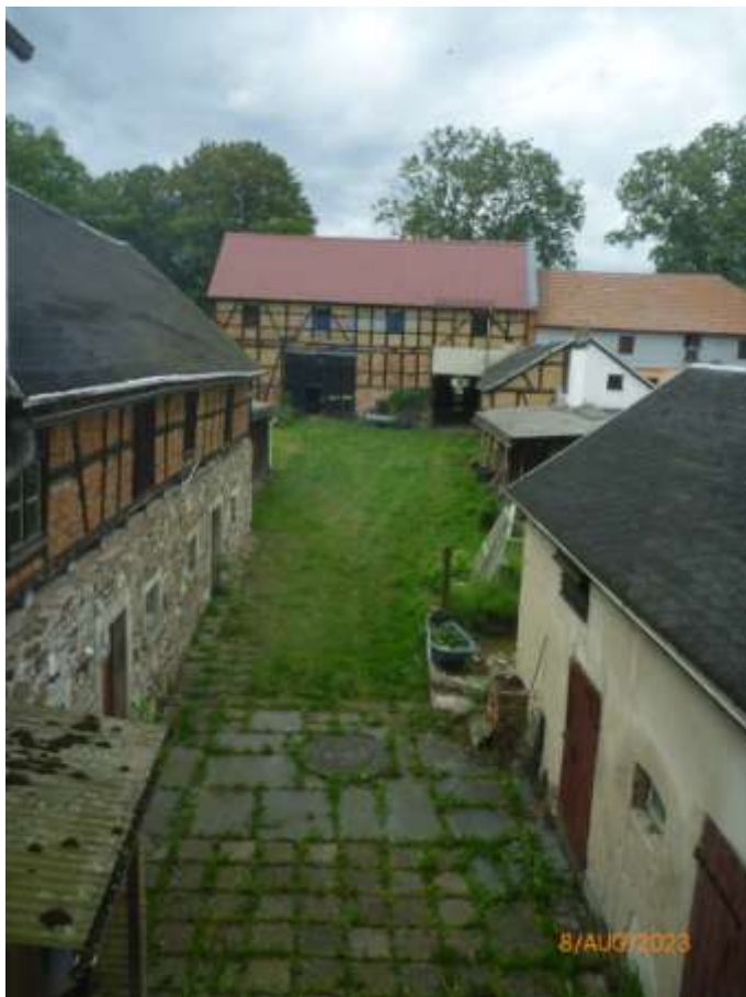
Bild 10: Blick vom Flur im Obergeschoss auf den Innenhof mit den Nebengebäuden und der Scheune im Hintergrund
