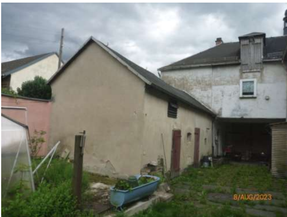
Bild 14: links der nordöstliche Wohnhausanbau; im Hintergrund das Wohnhaus mit der Tordurchfahrt; m Dachgeschoss die Gaube für den Lastenaufzug
