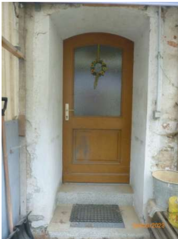
Bild 3: Eingang zum Wohnhaus
