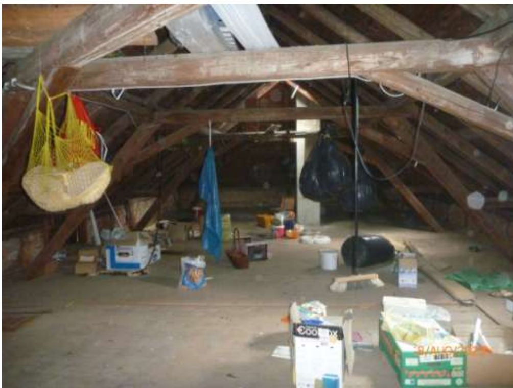
Bild 11: Dachboden im Wohnhaus
