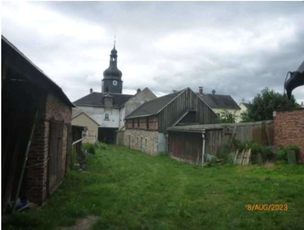
Bild 13: Blick von der Scheunendurchfahrt nach Süden in den Innenhof mit den verschiedenen Nebengebäuden; im Hintergrund die Kirche von Unterkoskau
