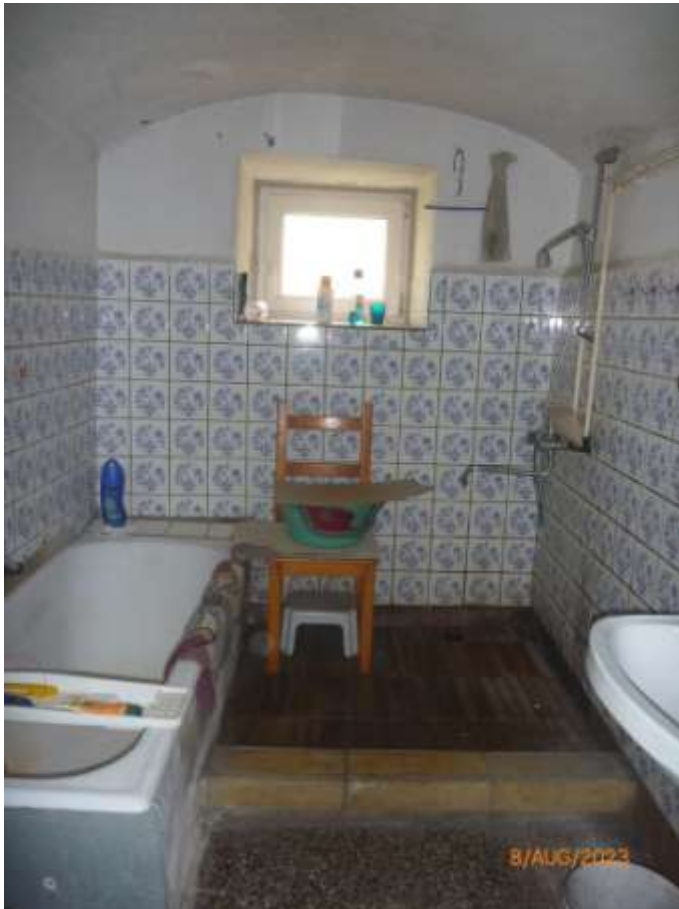
Bild 7: Bad/WC im Erdgeschoss mit Wanne, Dusche und Waschtisch
