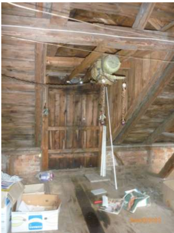
Bild 12: Dachboden mit Lasten- aufzug zum Innenhof
