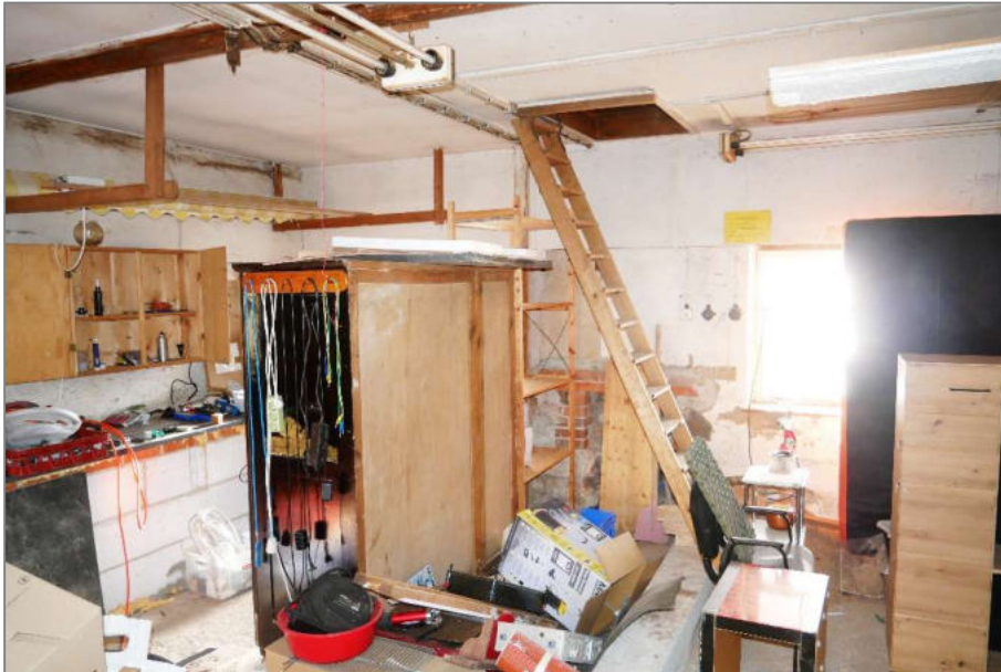
Foto 11 - Nebengebäude - Werkstatt EG
