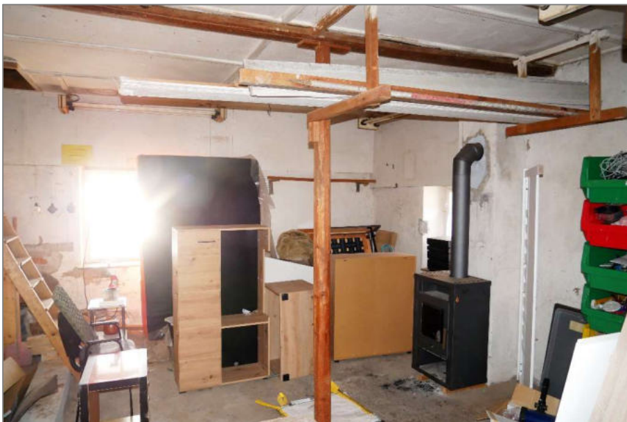
Foto 12 - Nebengebäude - Werkstatt EG
