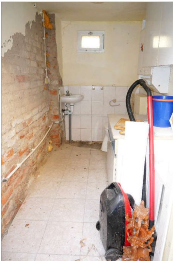
Foto 10 - Nebengebäude - Außentoilette EG
