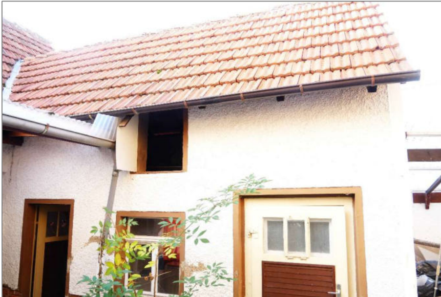
Foto 7 - Nebengebäude - westlicher Teil - Nordansicht
