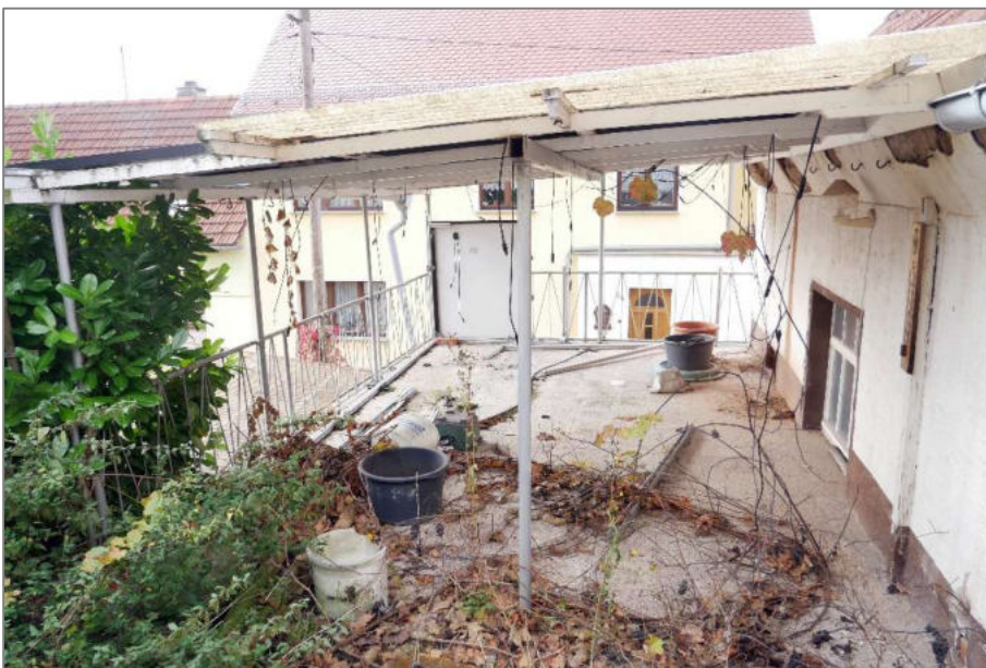
Foto 14 - Dachterrasse über der Garage
