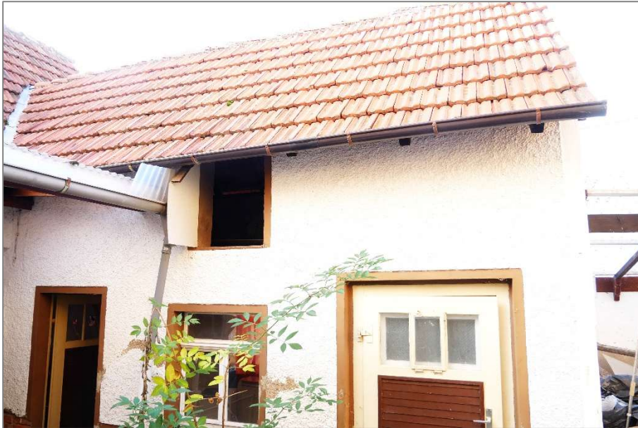
Nebengebäude - westlicher Teil - Nordansicht
