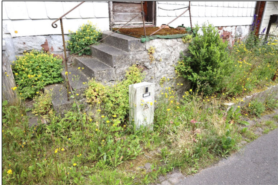
Hauseingang rechts mit Elektroanschluss
